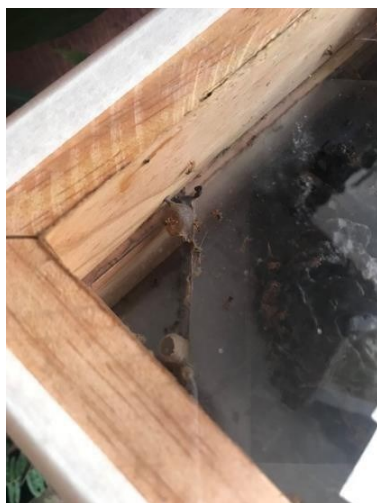
Figura 51: Construcción de potes adicionales
