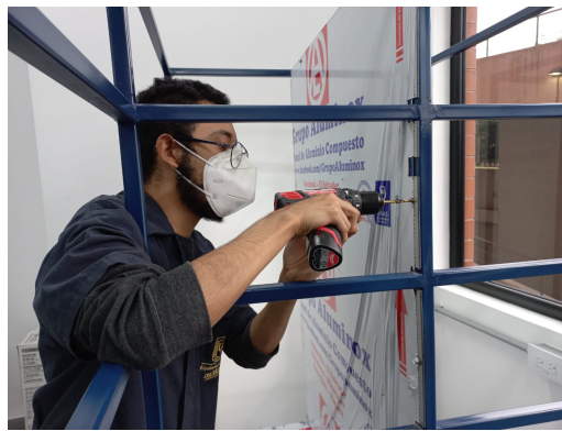
Figura 38: Proceso de taladrado e instalación de lámina de ACM en los soportes de la estructura del sistema de refrigeración
