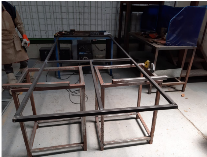
Figura 30: Mesas de apoyo para realizar las soldaduras de los elementos metálicos
