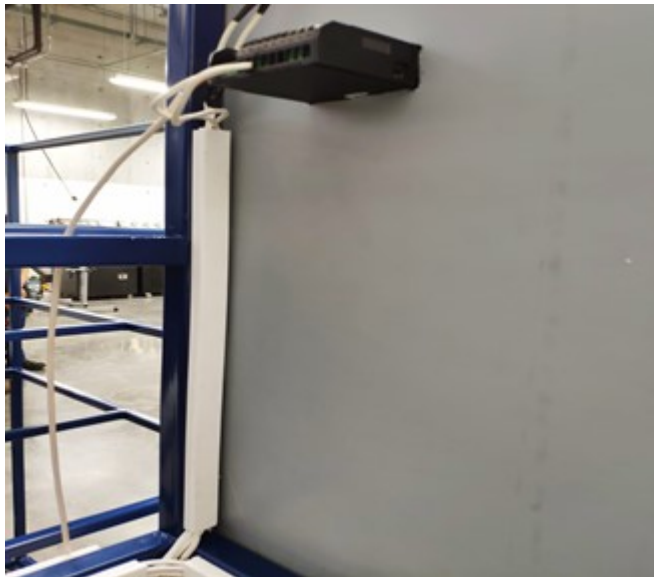
Figura 53: Instalación de canaletas verticales para sensores
