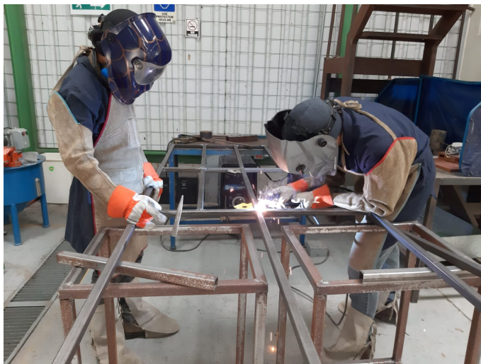
Figura 31: Proceso de soldadura del nivel no.1 del sistema de transferencia de calor.
