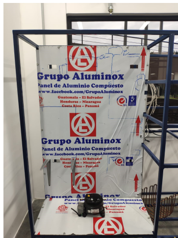
Figura 39: Láminas de ACM instaladas en el espacio del sistema de refrigeración
