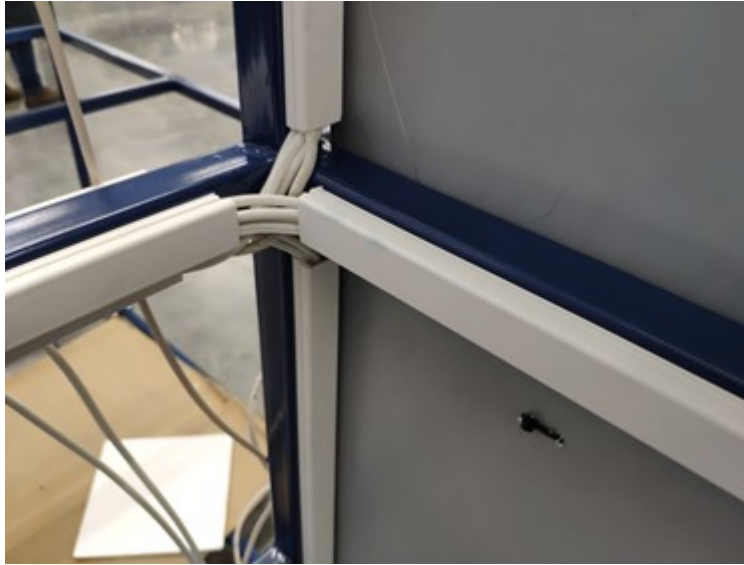
Figura 52: Instalación de canaletas horizontales
