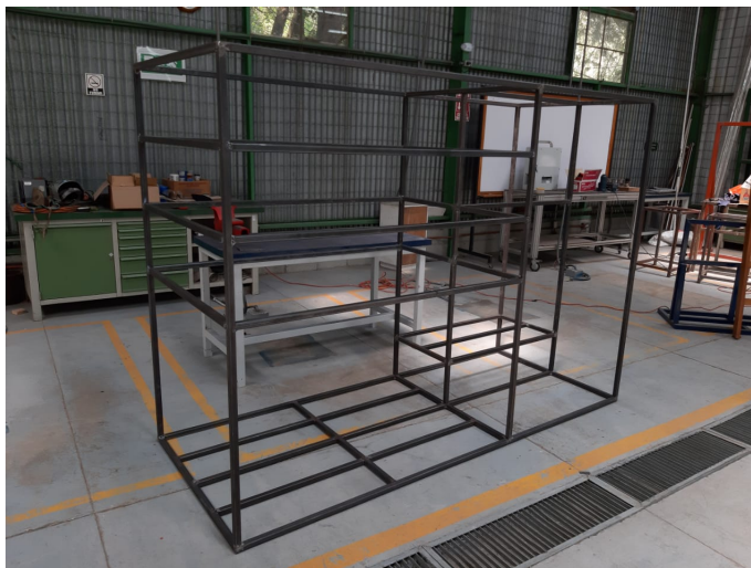
Figura 35: Construcción de estructura finalizada
