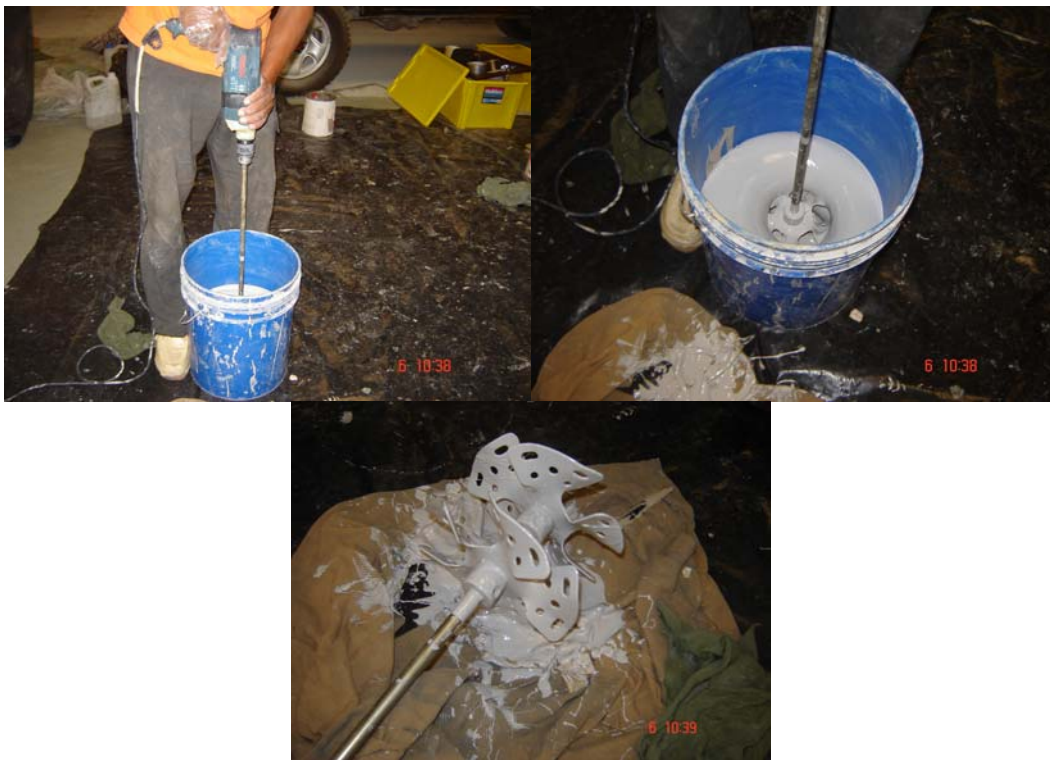
Imagen 1: Preparación de la mezcla con barreno.
