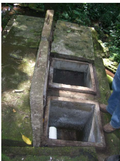
Ilustración 7 Caja desarenadora, Manantial "Las Nubes"
