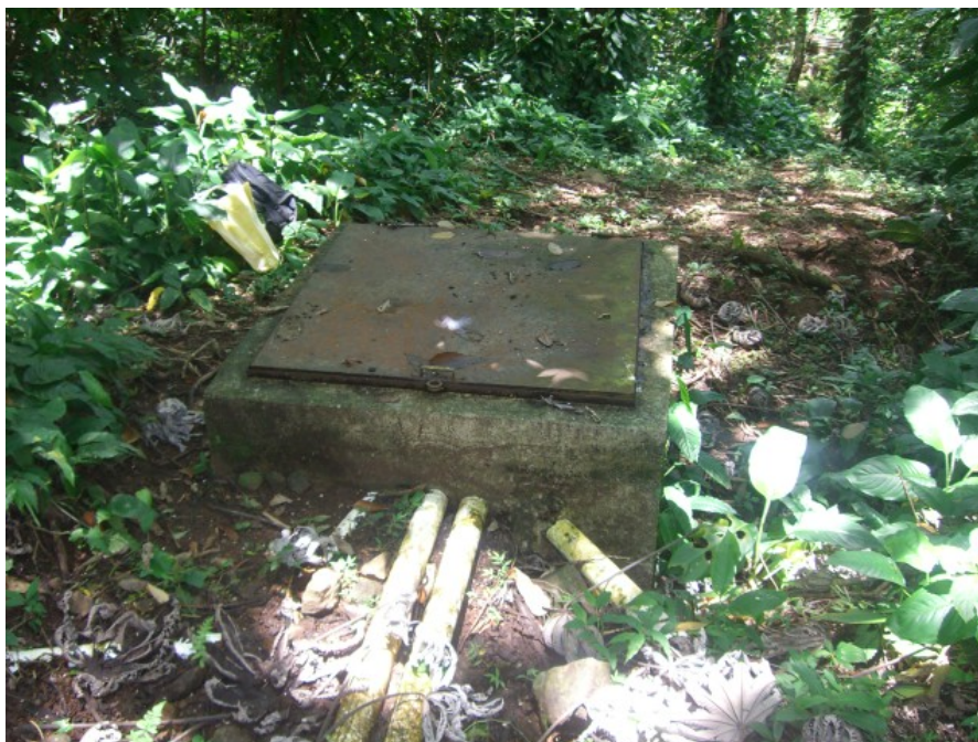
Ilustración 10 Caja unificadora Manantial “Vuelta Grande”
