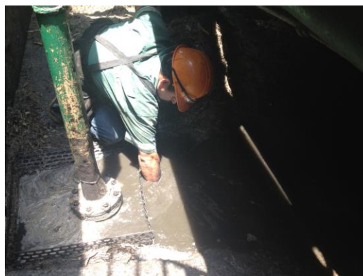
Figura 27. Mantenimiento realizado a la bomba succionadora (tándem B).
