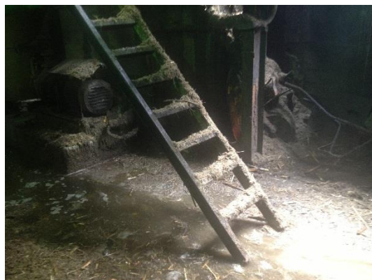
Figura 28. Mantenimiento preventivo, poca acumulación de bagazo y agua (tándem B).
