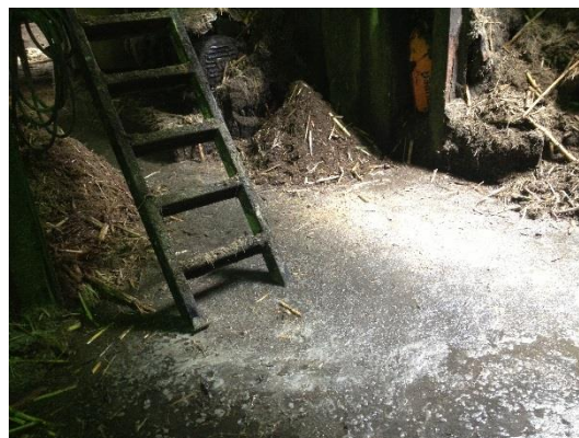
Figura 29. Mantenimiento correctivo, alta acumulación de bagazo y agua (tándem B).
