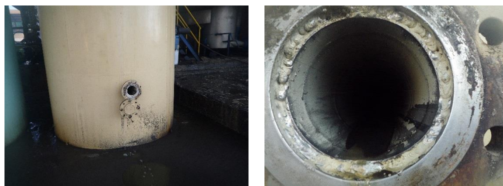
Figura 47. Presencia de material acumulado en taque de jugo mezclado en el tándem C del Ingenio Magdalena.FECHA: 8 FEBRERO 2013
