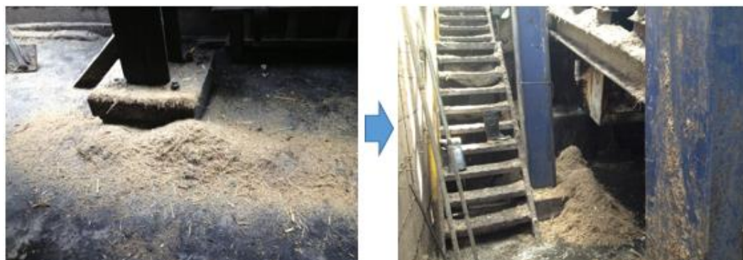
Figura No. 1 Bagazo en áreas de conductores
