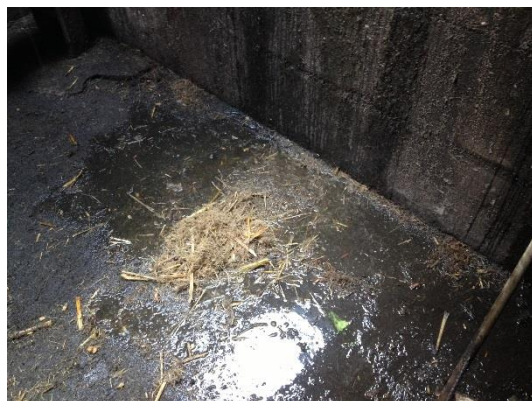
Figura 25. Mantenimiento preventivo, poca acumulación de bagazo y agua (tándem A)
