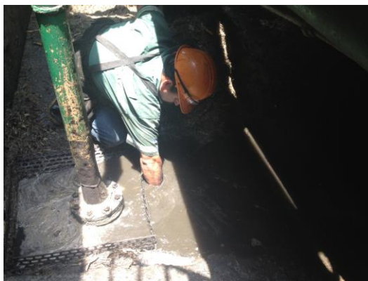
Figura No. 4 Nivel de bagazo acumulado adecuado y no adecuado en el área de la bomba succionadora del Tándem B
