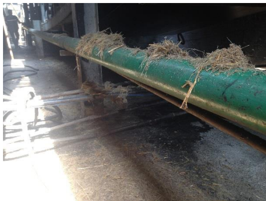
Figura 32. Mantenimiento preventivo de selladores
