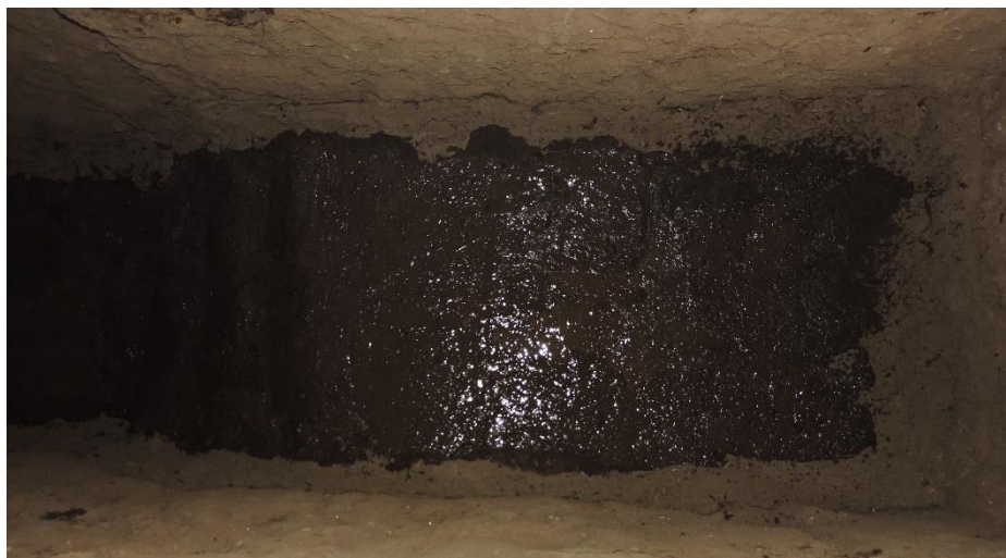
Figura III-8: Fotografía realizada el 23 de mayo de 2019 donde se observa la aplicación de una nueva mezcla (Foto por P. Estrada).
