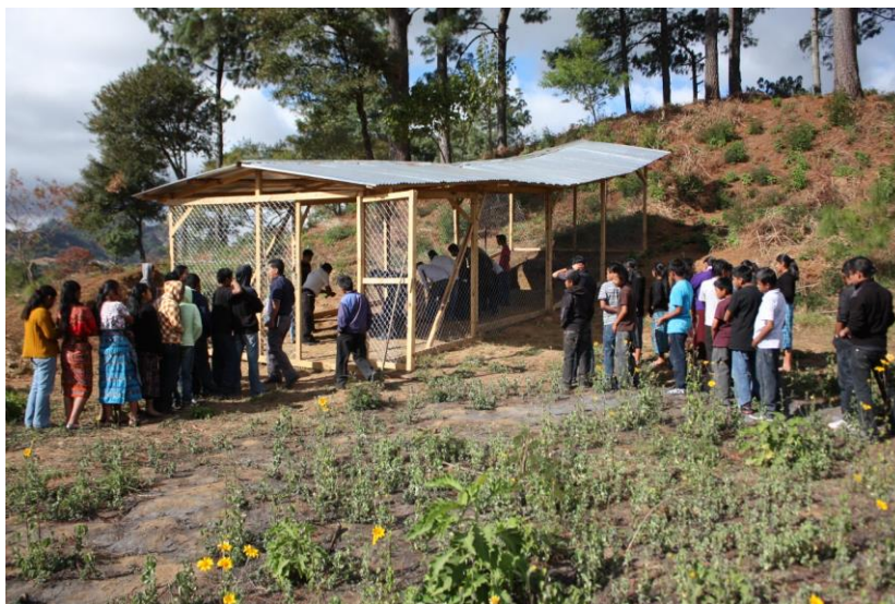
Figura III-1: Cubierta de lámina y madera realizada en el año 2012 sobre la Escalinata de la Estructura 12 (Foto por C. Alvarado).
