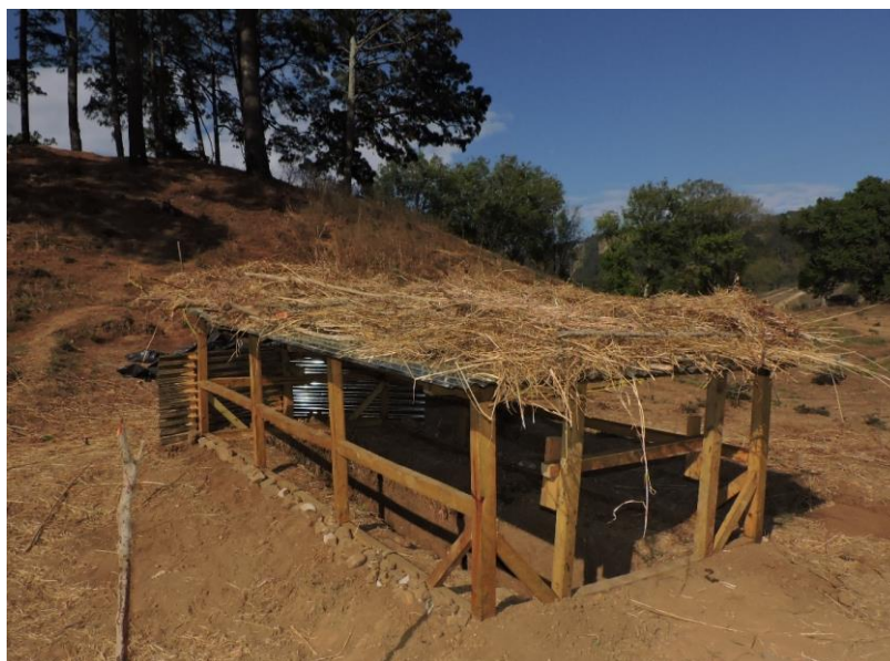
Figura III-5: Cubierta sobre la escalinata de la Estructura 16 (Foto por P. Estrada).
