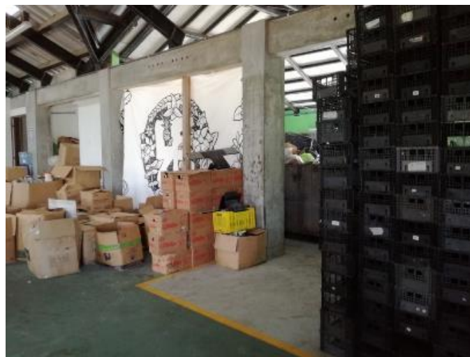
Figura 120: Riesgo por caídas de objetos
