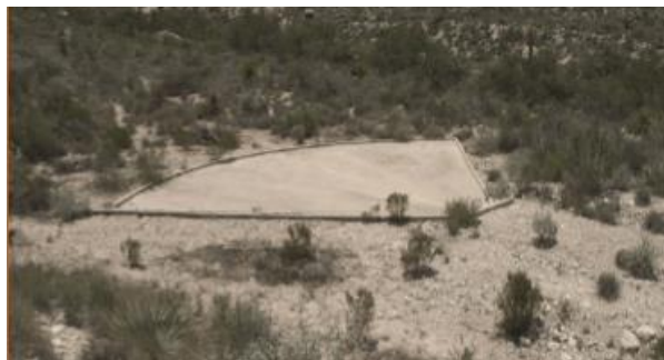
Figura 19. Ladera recubierta con concreto en forma de abanico.
