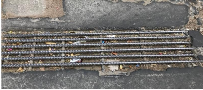
Figura 43. Tragante de agua tapado.
