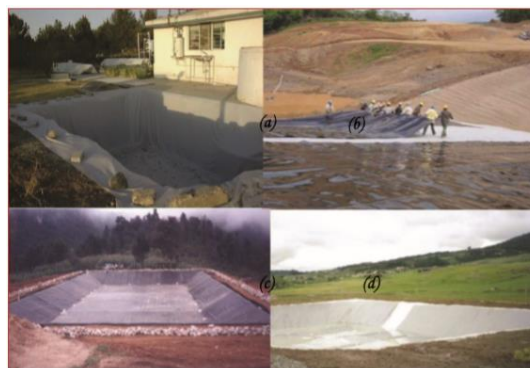
Figura 26. Cisternas de geomembrana y polietileno
