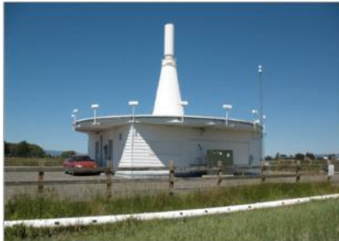
Figura 30. Instalación de radiofaro omnidireccional de alta frecuencia (VOR) en ruta.
