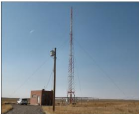
Figura 34. Instalación de radiofaro no direccional (NDB).
