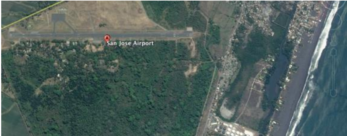
Figura 45. Aeropuerto del Puerto de San José
