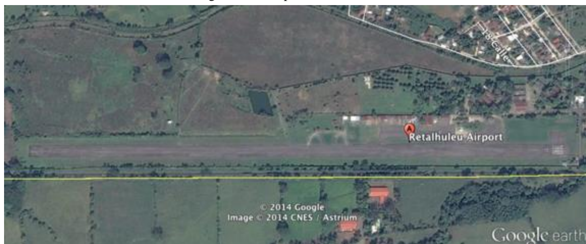
Figura 47. Aeropuerto de Retalhuleu
