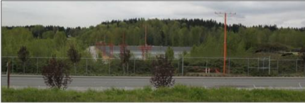
Figura 17. Infraestructura para MALSR
