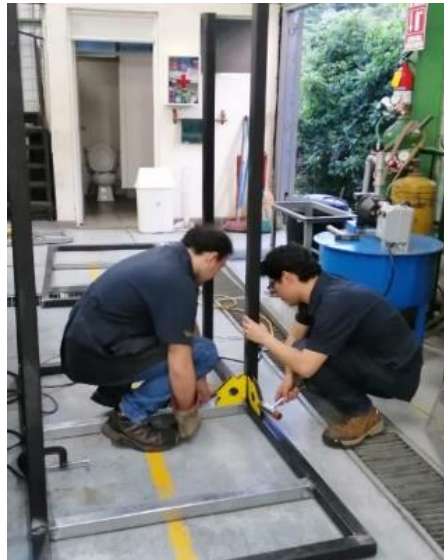
Ilustración 75 Soldadura de paraleles de conexión con escuadras magnéticas
