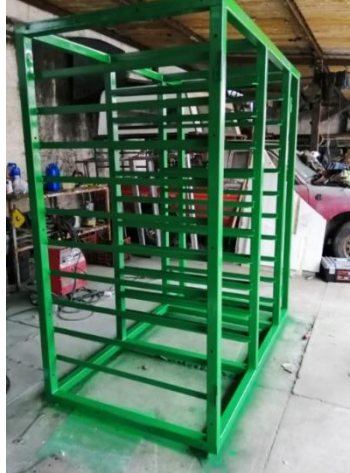
Ilustración 88 Aplicación de capa de pintura anticorrosiva a estructuras.
