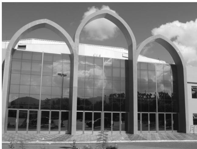
Fotografía no. 1: Fachada del templo de la Iglesia El Shaddai
