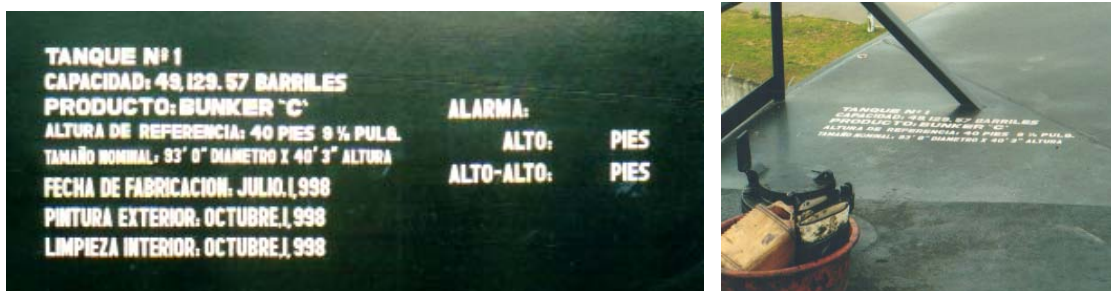
Foto No. 4: Indicaciones en el tanque de bunker.
