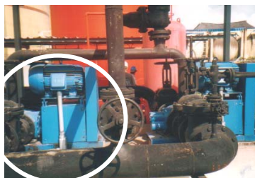
Foto No. 11: Planta eléctrica descompuesta.
