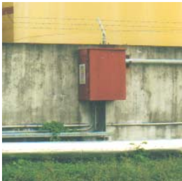
Foto No. 44: Control de resistencias.
