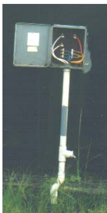
Foto No. 9: Protección catódica de los tanques.
