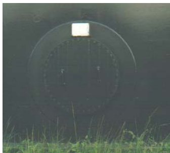
Foto No. 15: Entradas de personas a los tanques.
