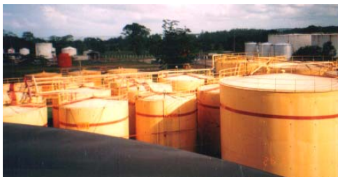
Foto No. 17: Planta vecina con poca distancia entre sus tanques de aceite vegetal
