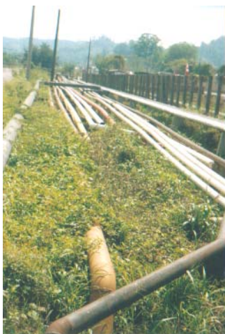
Foto No. 38: Tuberías sobre el monte a la orilla del muelle.
