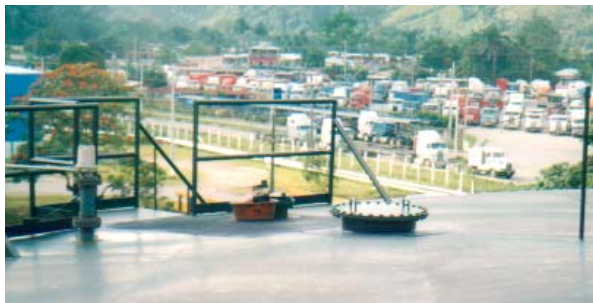
Foto No. 15: Entradas de personas a los tanques.
