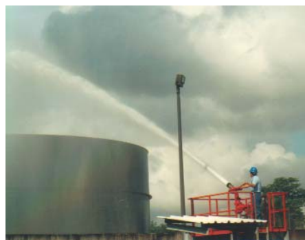
Foto No. 50: Empleado de BQF probando la manguera de un extintor estacionario.
