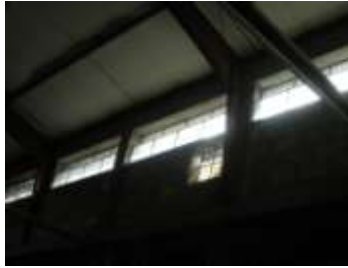
Figura # 18: Iluminación y ventilación en el área de trabajo a través de las ventanas
