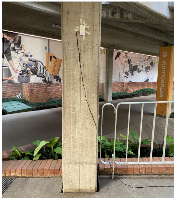
Figura 55: Forma de colocar los módulos sobre las columnas y soportes
