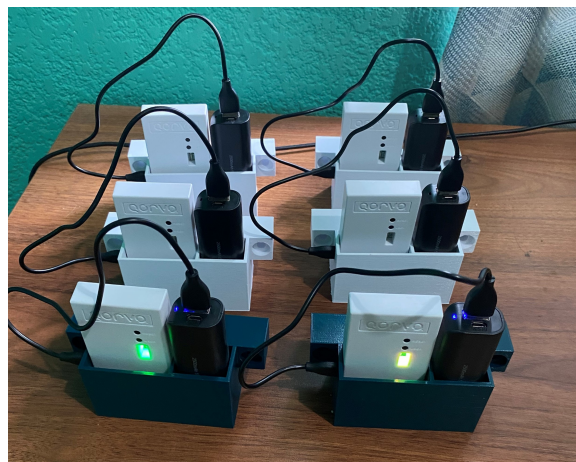
Figura 66: Prueba con módulo y baterías para ver porqué se apagaban
