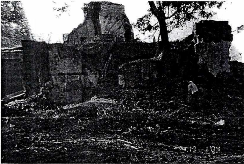
Figura 7 Capilla, estado al inicio de la investigación Fuente: Archivo, Proyecto Santo Domingo
