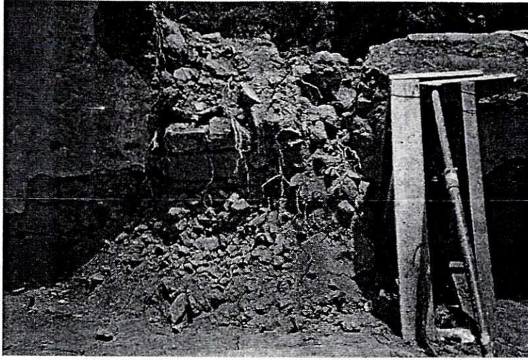
Figura 58 Antecocina, tapia de la puerta de acceso Fuente: Archivo, Proyecto Santo Domingo
