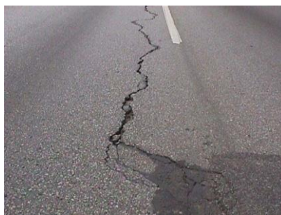
Ilustración 7. Fisuración longitudinal.
