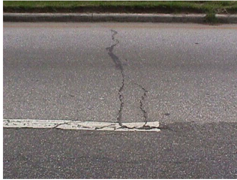
Ilustración 8. Fisuración transversal.
