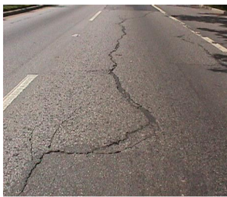
Ilustración 10. Consolidación del terreno de cimentación.
