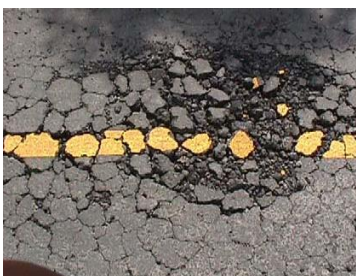
Ilustración 5. Fisuración en Piel de Cocodrilo Severidad Alta.
