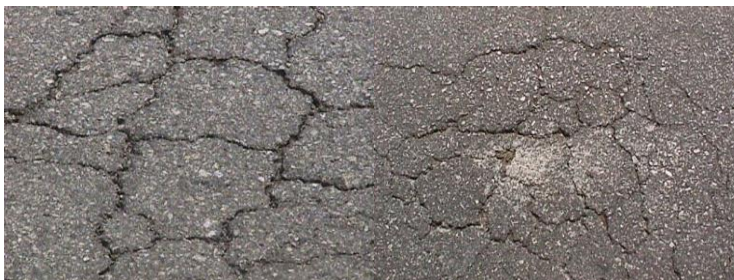
Ilustración 5. Fisuración en Piel de Cocodrilo Severidad Alta.
