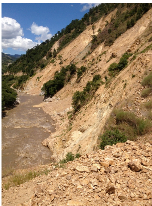
Ilustración 20: Área con riesgo de deslizamiento, Sacuapulas.
