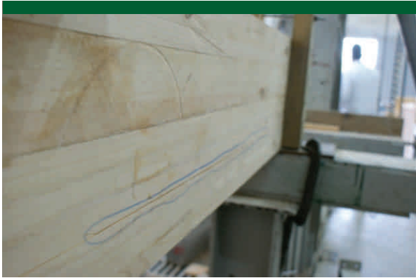
Gráfica 3. Falla de la viga # 2.
