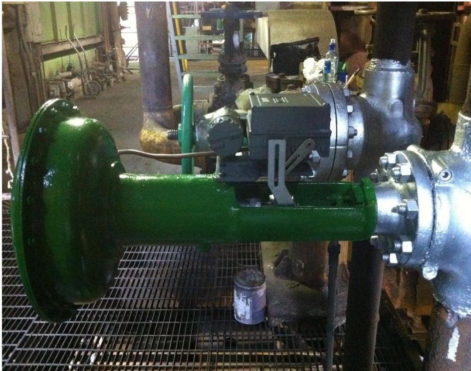
Figura 31. Imagen de la válvula automática de control (Vista frontal)
