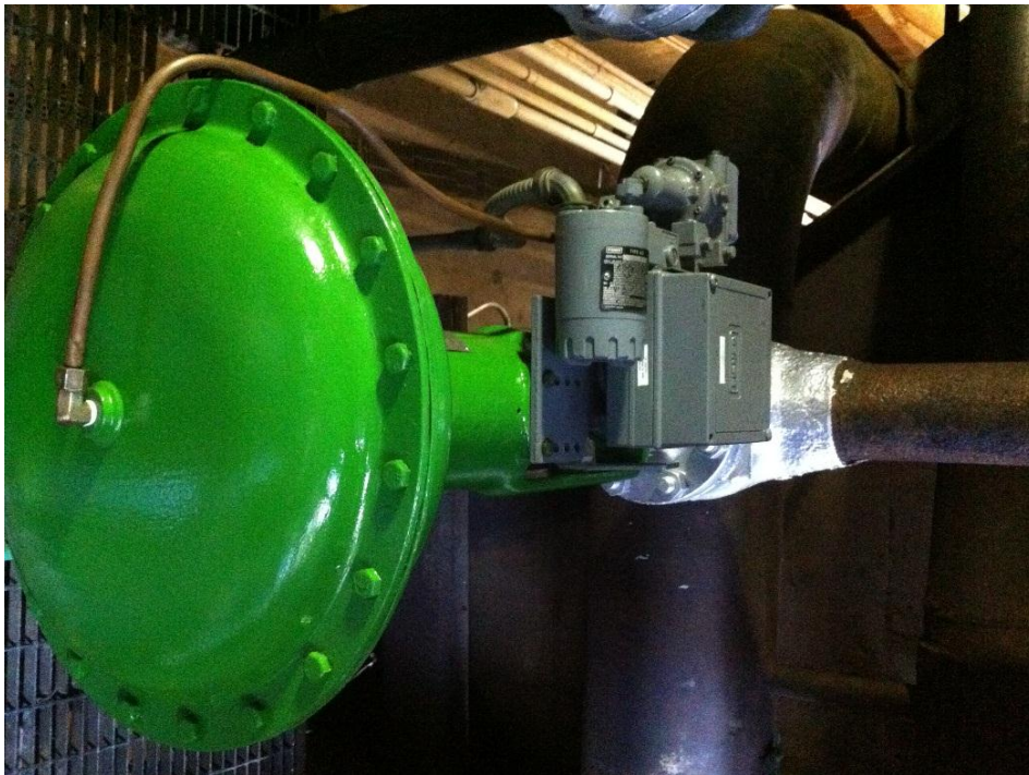
Figura 31. Imagen de la válvula automática de control (Vista frontal)
