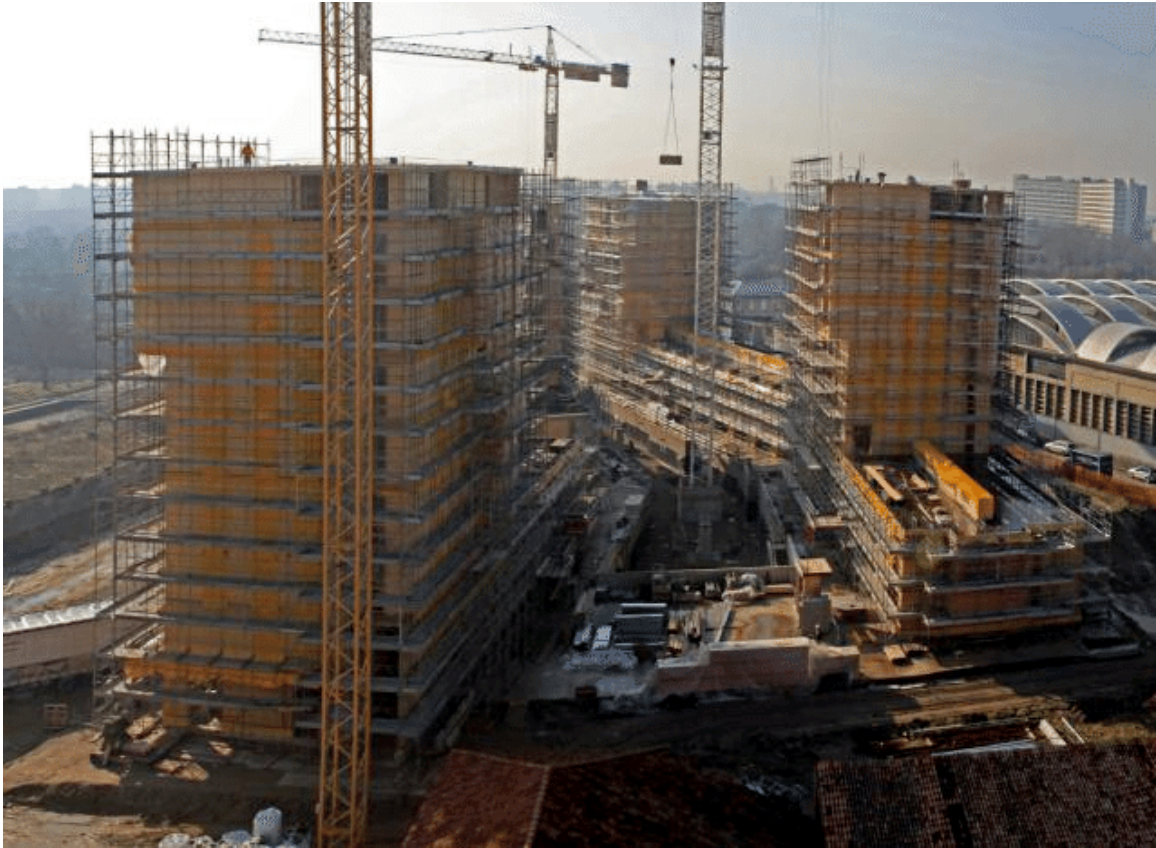
Figure 27: Edificio en construcción en Milan Italia Adaptado de Gasparri et. al., 2016
