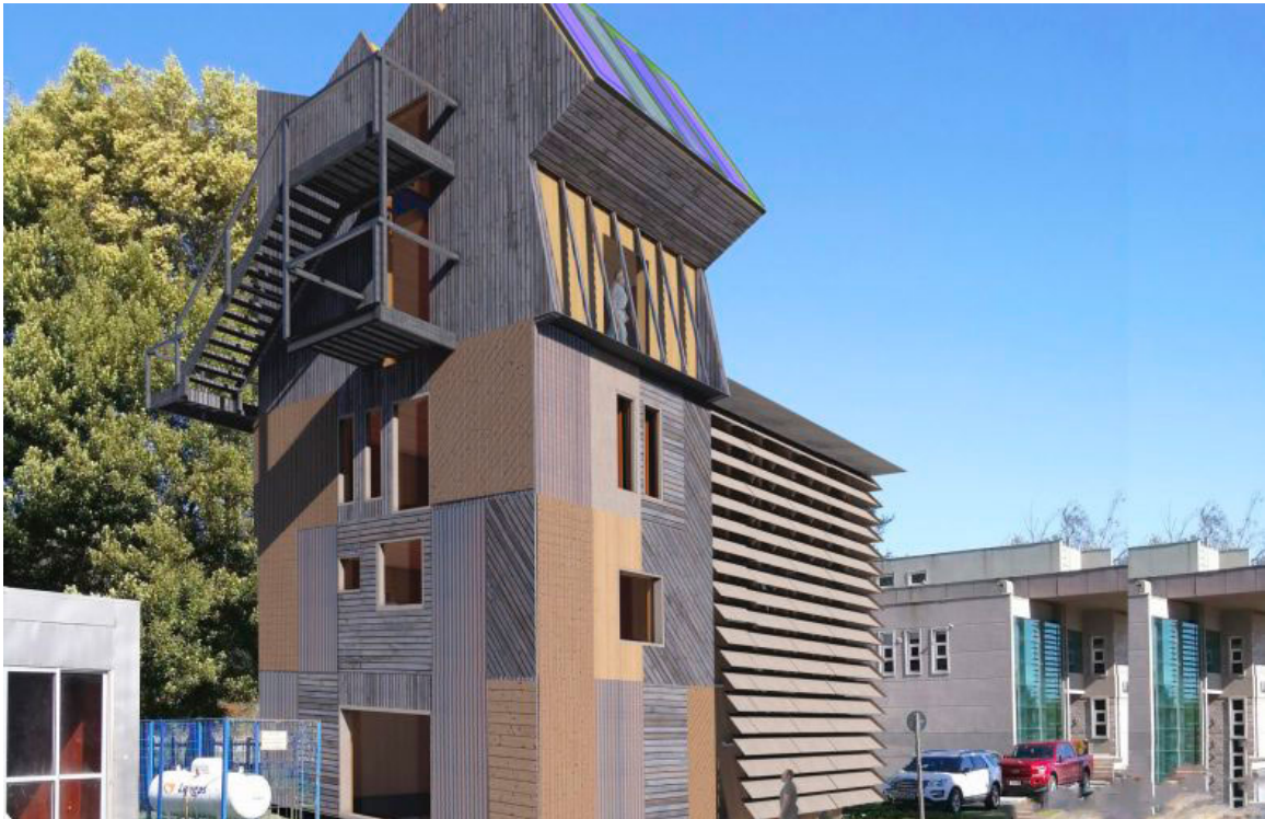
Figure 25: Edificio Experimental de CLT en campus UBB Adaptado de Falk et. al., 2016
