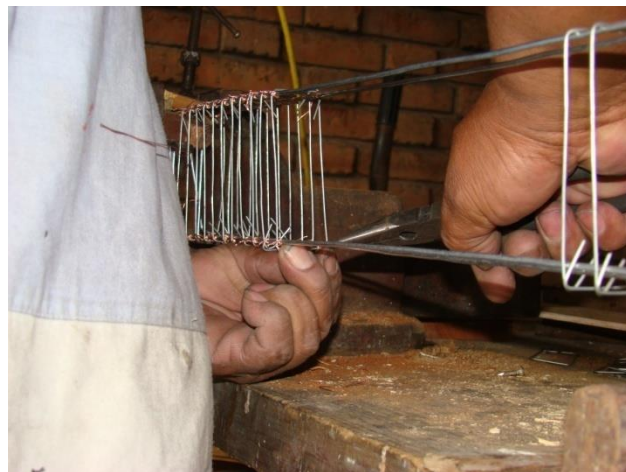
Figura 60. Estribos utilizados como refuerzo de corte.
