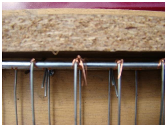
Figura 62. Amarre entre estribos y refuerzo principal.
