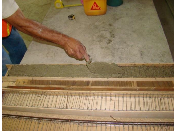
Figura 65. Fundición de la viga.
