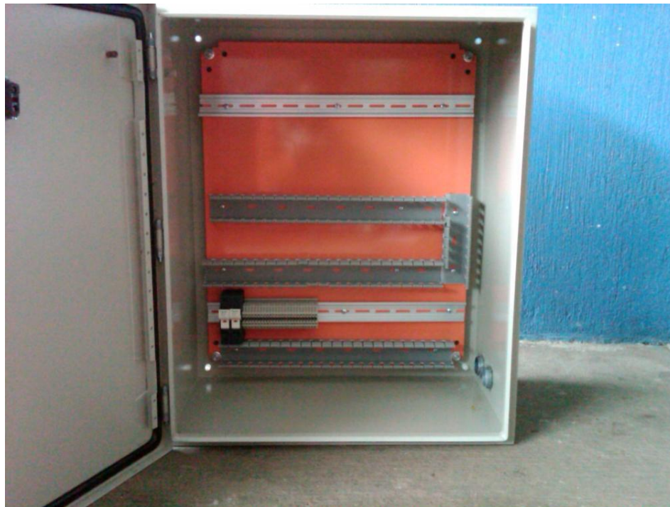
Ilustración 55. Instalación de rieles y canaletas en el gabinete
