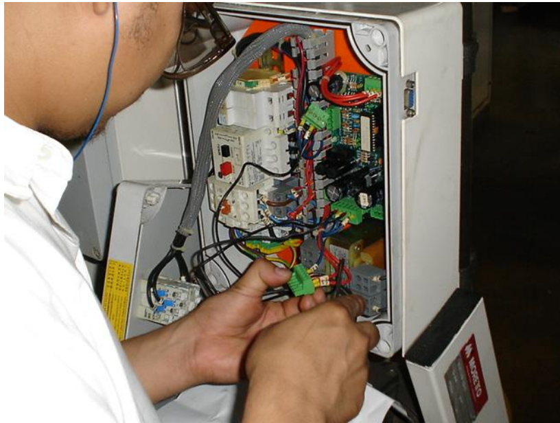
Figura 10. Cambio de relé de estado sólido.
