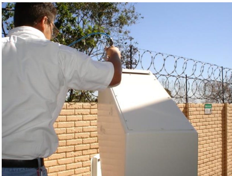
Anexo 4. Aplicación de pintura a estructura externa del molino.
