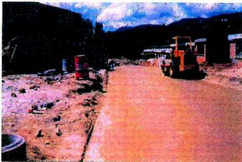
COMPACTACION CON VIBROCOMPACTADOR
