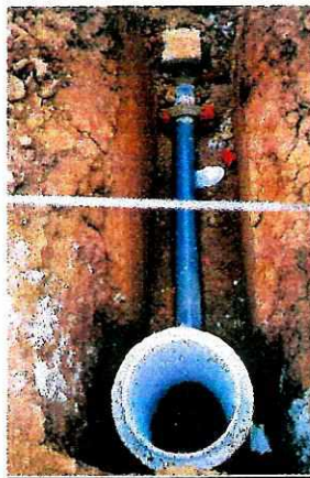
CONEXION DE CANDELA DE AGUAS NEGRAS
