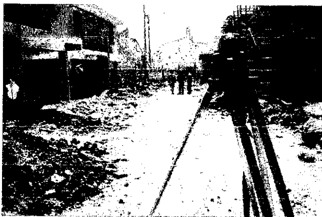
TOPOGRAFIA EN CALLE
