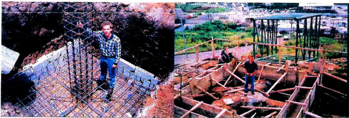
ARMADURA ZAPATAS
