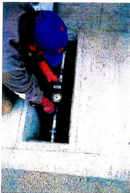
COLOCACION CONTADORES DE AGUA
