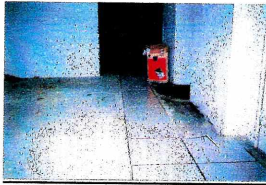
COLOCACION PISO CERÁMICO
