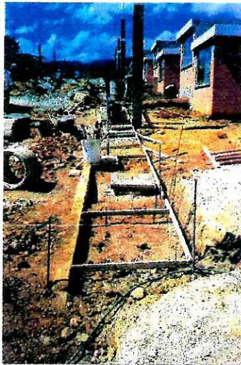
FUNDICION BANQUETA Y BORDILLO
