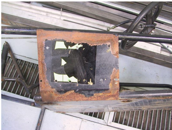
Figura 96: Lado lateral derecha de la estructura del vehículo.
