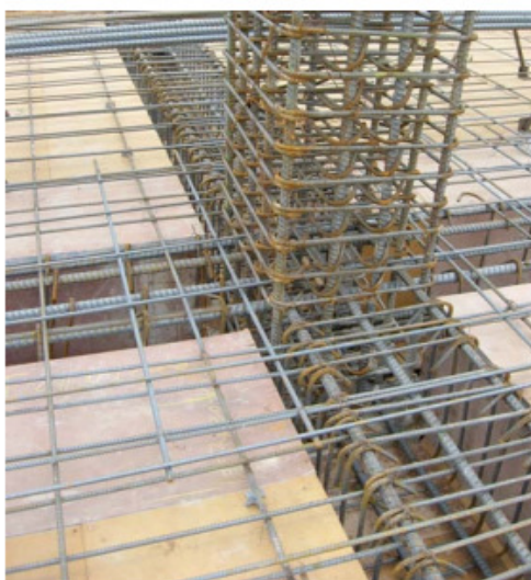
Figura No. 3 Confinamiento de nudos columna-viga.
