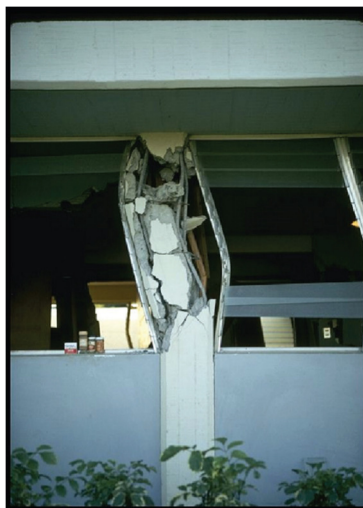
Figura No. 7 Ejemplo de efecto de columna corta.
