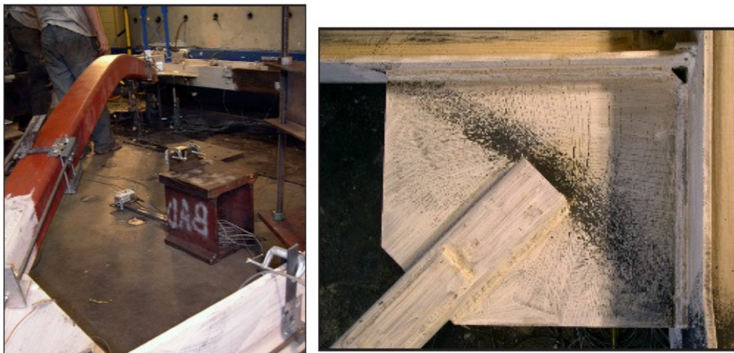
Figura No. 18 Riostra fallada por pandeo y placa de unión deformada
