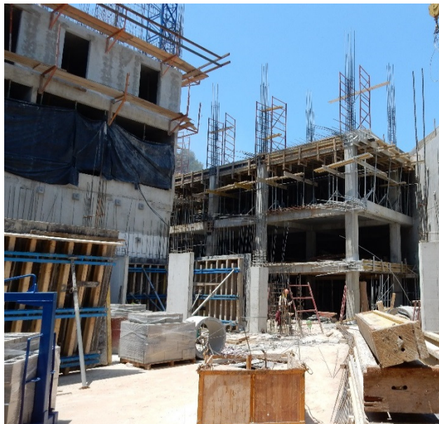
Figura No. 9 Edificio de Oficinas en la Zona 5
