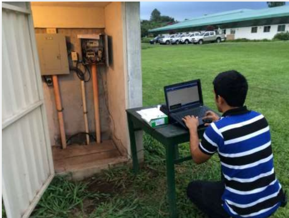
Figura 23. Carga de programa desde PC hacia Zelio
