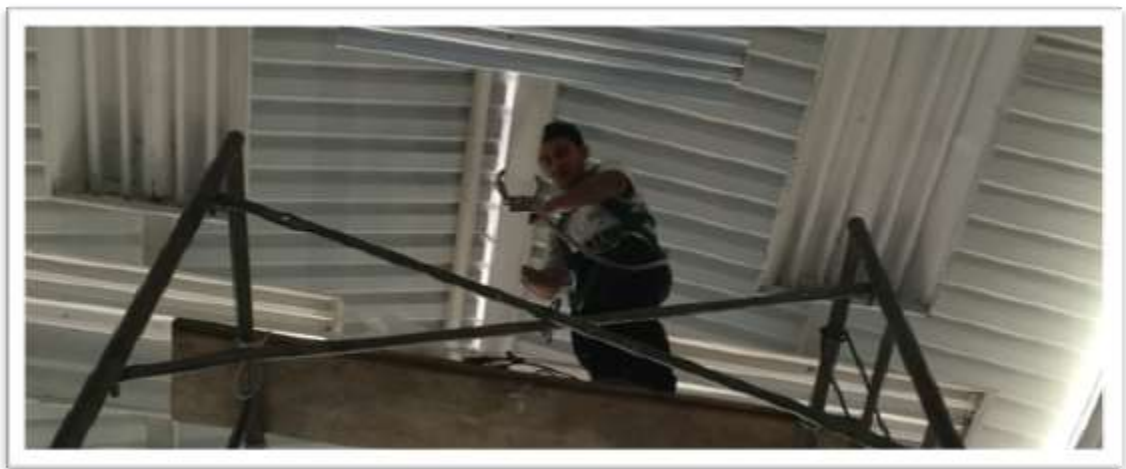
Figura 14. Instalación de elementos de iluminación
