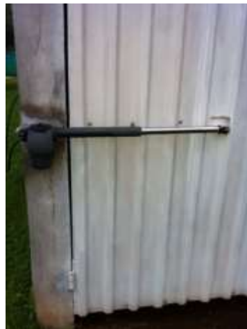
Figura 19. Brazo eléctrico para apertura del portón de cámara de fotoperíodo
