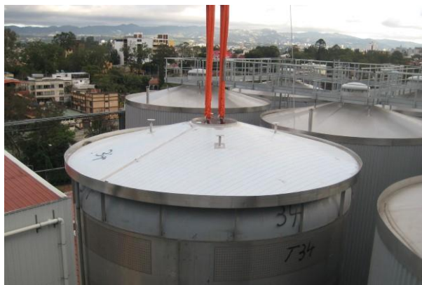
Figura 25. Techo y primeros anillos del tanque
