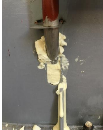
Figura 51. Espuma de poliuretano dentro del tanque
