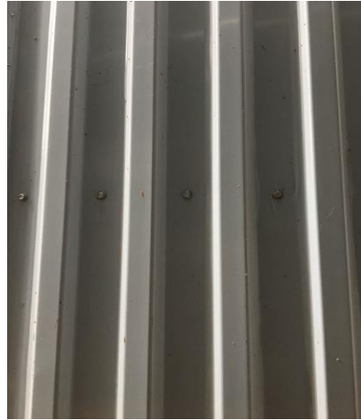
Figura 49. Laminas instaladas por medio de pernos
