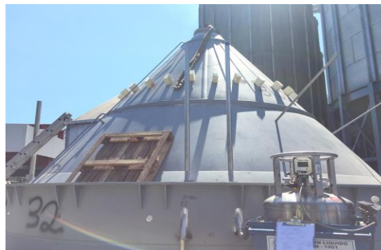
Figura 36. Cono principal con tuberías ensambladas
