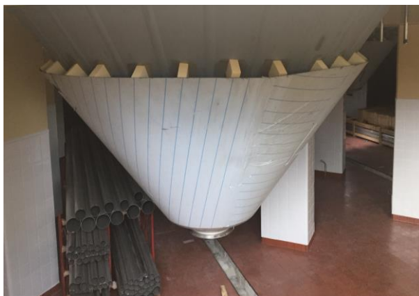
Figura 27. Cono ensamblado al cimiento del proyecto
