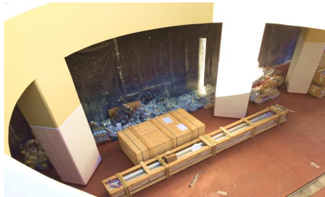
Figura 29. Dos de las cuatro columnas que soportan el peso de manera distribuida
