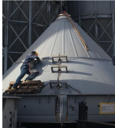
Figura 35. Ensamble del cono al semicono por medio de soldadura
