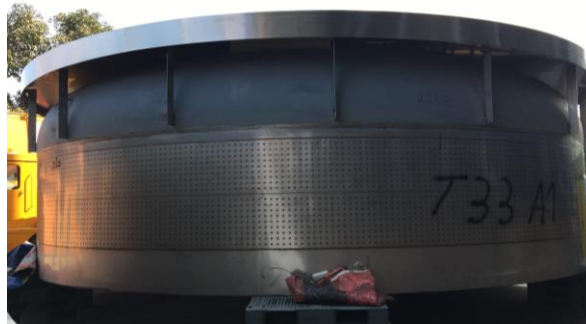
Figura 39. Ensamble del techo toriesférico con el primer anillo
