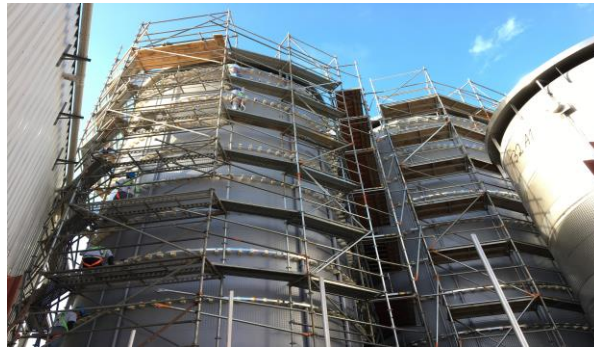
Figura 32. Montaje de andamios industriales previo al proceso de instalación de aislamiento térmico
