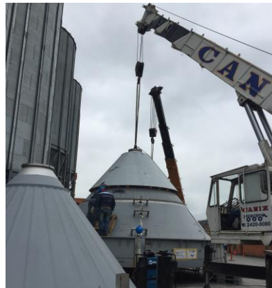
Figura 34. Traslado de cono por medio de la brida instalada por pernos
