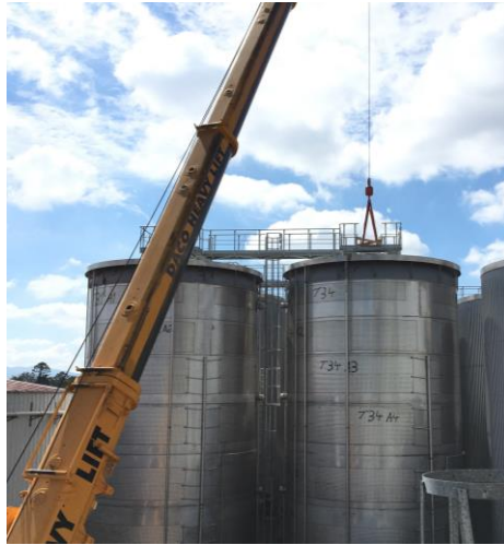
Figura 40. Pasarelas montadas en la parte superior del tanque
