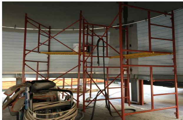
Figura 31. Andamios simples ensamblados
