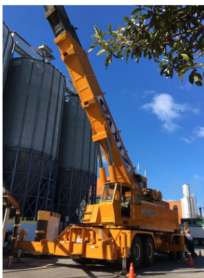
Figura 7. Grúa autopropulsada de 80 toneladas
