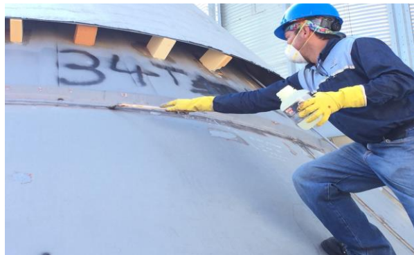
Figura 18. Aplicación del líquido penetrante en las líneas de soldadura
