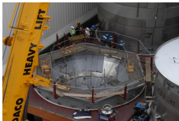
Figura 26. Semicono ensamblado al cimiento del tanque por medio de pernos
