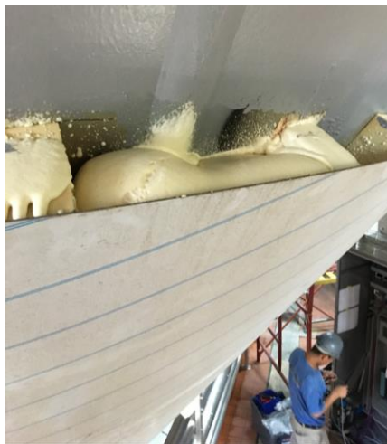
Figura 12. Aislamiento de espuma de poliuretano
