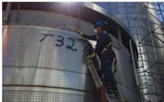
Figura 52. Aplicación de líquidos penetrantes en las soldaduras
