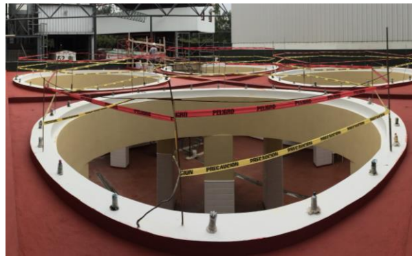
Figura 28. Cimiento con veinticuatro pernos para el tanque a montar
