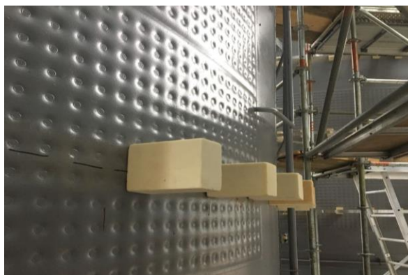
Figura 46. Espumas separadoras pegadas al tanque por medio de adhesivo
