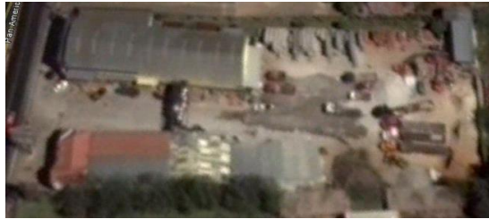
Figura 1 Vista superior de ferretería
