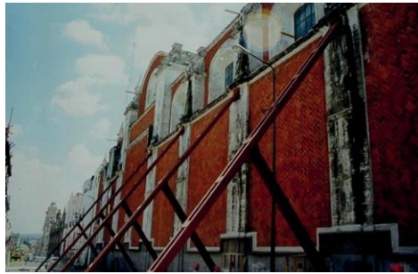
Figura 31. Almacén de pólvoras de la anterior Cárcel de Valparaíso en Chile, con vigas, pasarelas y refuerzos estructurales.
