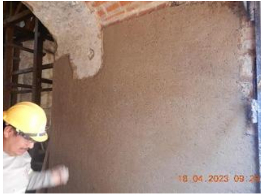
Figura 7. Integración de repello a base de cal en diferentes áreas de la sacristía, Templo de la Concepción.
