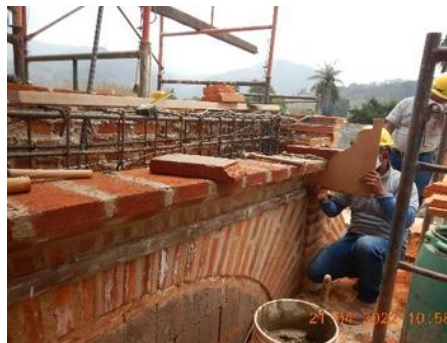
Figura 5. Tallado manual de ladrillo, Santa Clara.
