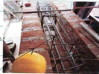
INTEGRACION DE CAJUELA DE LADRILLO + ARMADURA DE SOLERA DE ANCLARE
