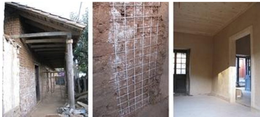
Figura 25. Aplicación de malla electrosoldada como refuerzo en muros de adobe. Recuperación de viviendas en Vichuquén.
