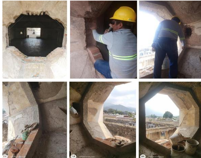
Figura 19. Integración de material faltante en marcos de ventanas, Templo de la Concepción.
