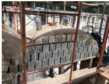
Figura 4. Cimbra provisional con block pómez ocupando el grosor del arco, Santa Clara.
