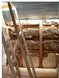
Figura 27. Sistema de consolidación de muros de adobe con exoesqueleto de madera.
