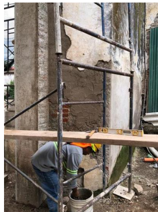
Figura 10. Integración de repellos a base de cal y consolidado de los aplanados originales, Nuestra Señora de los Remedios.
