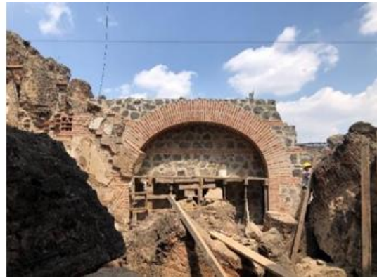
Figura 6. Integración de solera de amarre en bóveda y muros, sector oriente, San Agustín.
