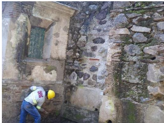
Figura 9. Limpieza de los muros externos del altar mayor para el proceso de consolidación, Dolores del Cerro.
