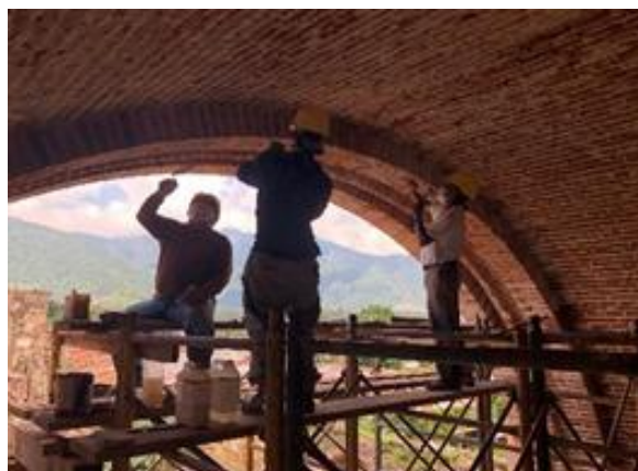
Figura 21. Tallado de la parte interna (intradós) de la bóveda oriente.
