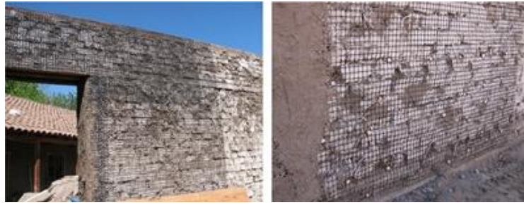
Figura 26. Refuerzo de muros de adobe con geomalla en recuperación de monumentos.
