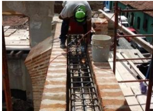
Figura 14. Armado de solera en Templo de la Concepción.
