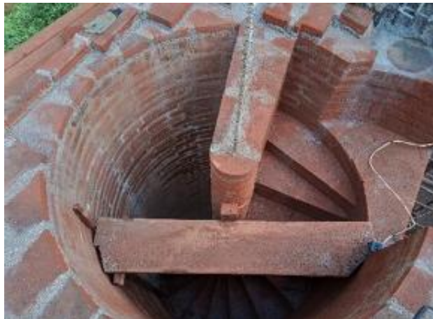
Figura 22. Finalización de gradas de caracol.
