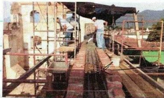
INTEGRACIÓN DE ARMADURA DE SOLERA
