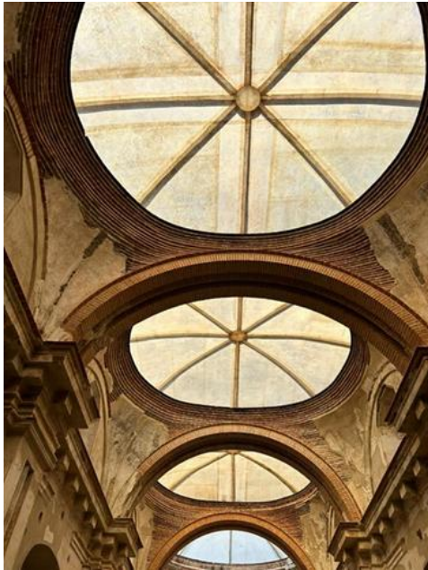
Figura 20. Recepción de trabajos, Santa Clara.
