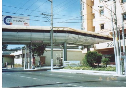
Foto No.6 puente peatonal Centro Médico Fuente: foto digital Arq. Ortiz
