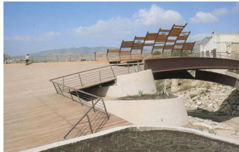
Figura No. 25 vista del tablero e integración del puente con el entorno.
