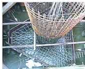
Figura No.37 esquema de las pilas laterales y su cimentación.
