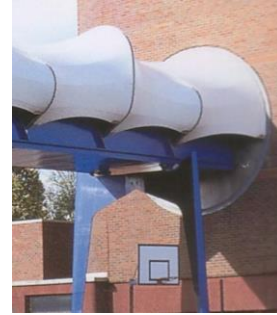
Figura No.20 unión del puente peatonal con el muro de mampostería del edificio de la escuela secundaria
