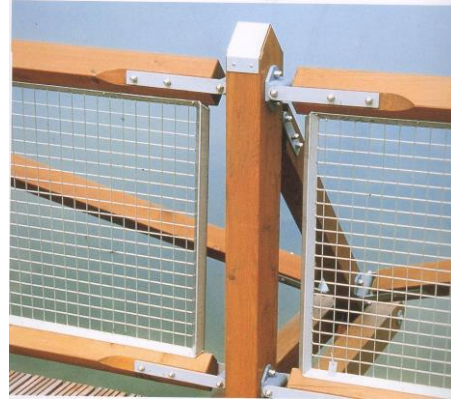
Figura No. 28 baranda de madera y conexiones de metal. Puntales de madera formando triángulo.
