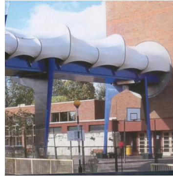
Figura No. 17 viga unida con el diafragma apoyada directamente sobre la pila de acero.
