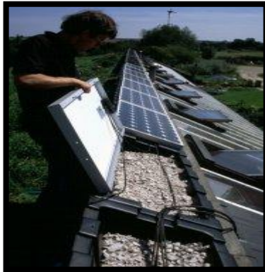
Ilustración 190. Instalación de paneles solares en el techo.
