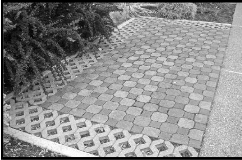
Ilustración 255. Grilla de concreto con celda abierta rodeando adoquines. (Repetida)
