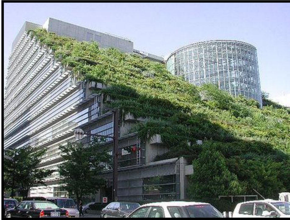
Ilustración 104. Techo verde en edificio moderno en Chicago.
