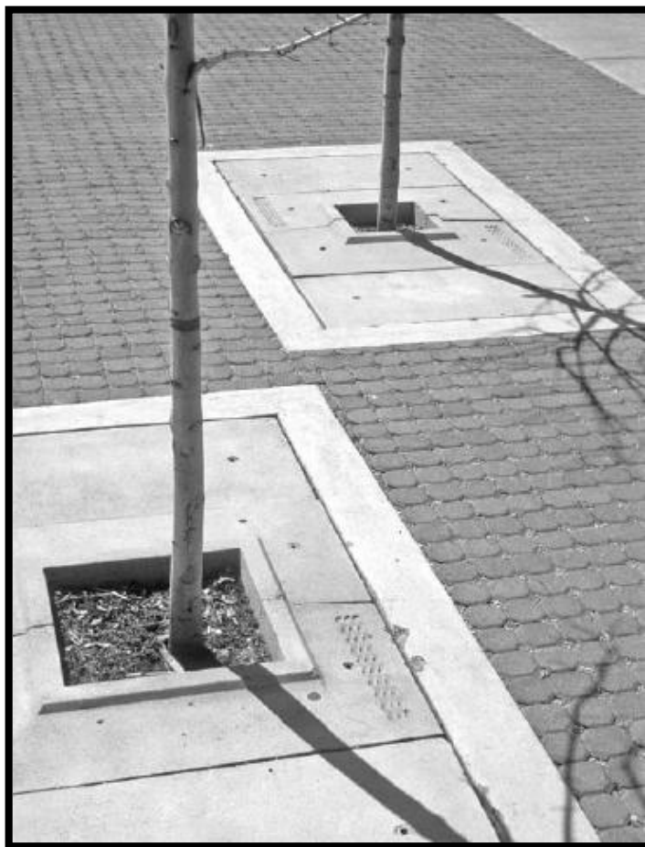
Ilustración 99 .Adoquines de junta abierta próximos a plantaciones de árboles.
