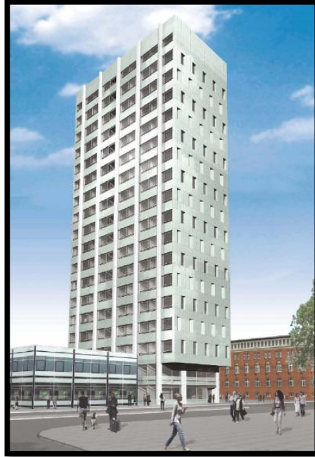
Ilustración 155. Torre de oficinas Kaiserhof en Hamburgo.
