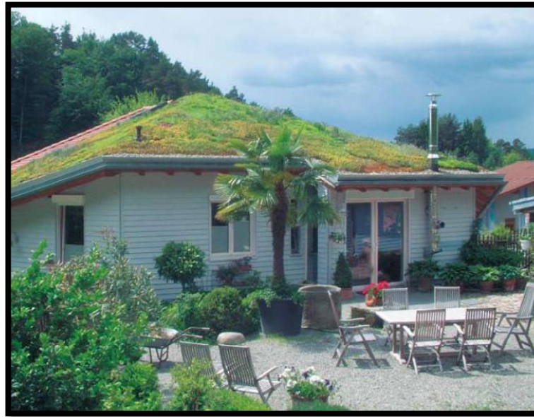
Ilustración 105. Techo verde residencial.
