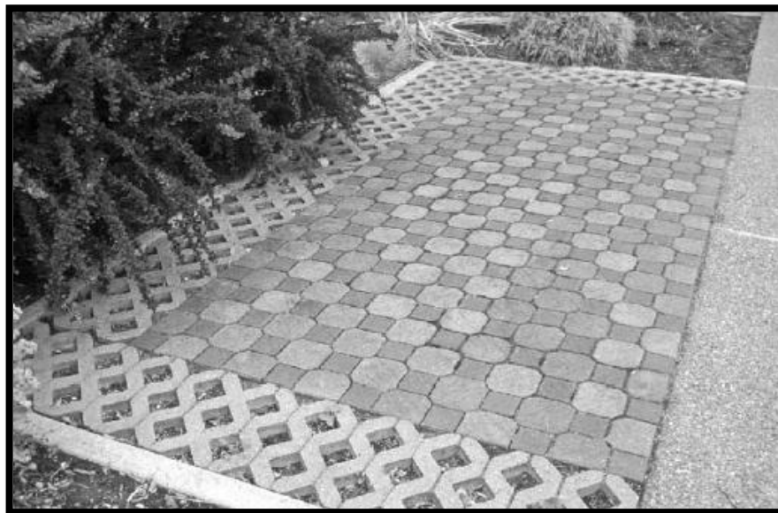
Ilustración 100. Grilla de concreto con celda abierta rodeando adoquines sólidos.
