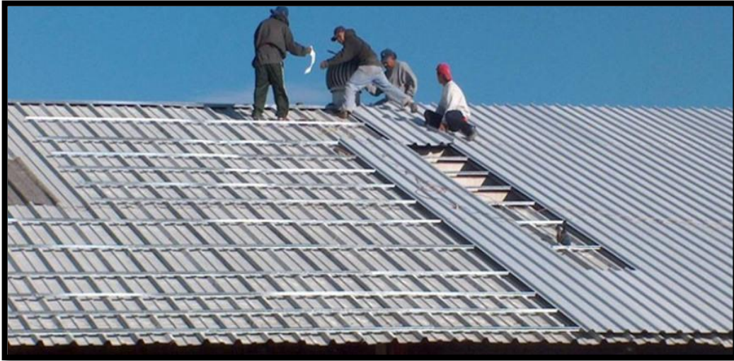
Ilustración 123. Instalación de lámina termoacústica.
