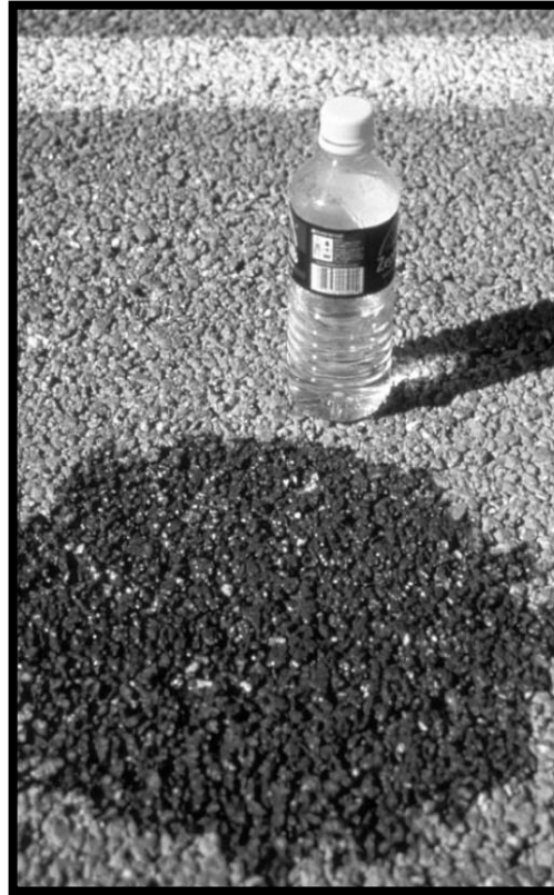
Ilustración 90. Infiltración en la superficie de concreto poroso de un parqueo.
