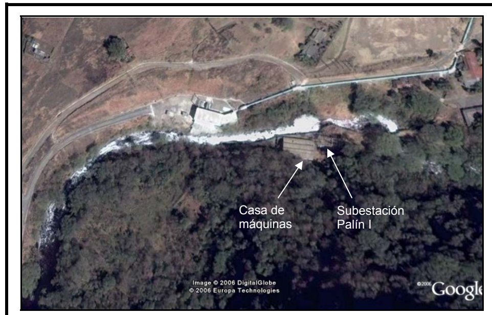
Figura 14 Vista satelital de casa de máquinas y subestación Palín I
