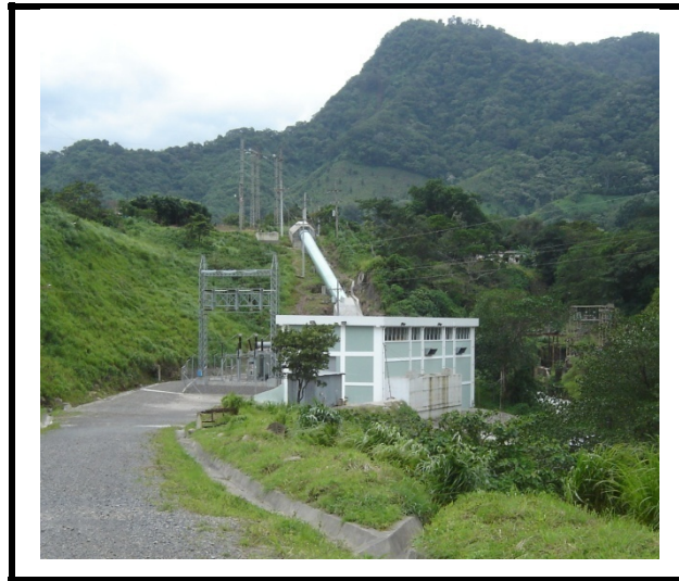
Figura 16 Casa de máquinas Palín II
