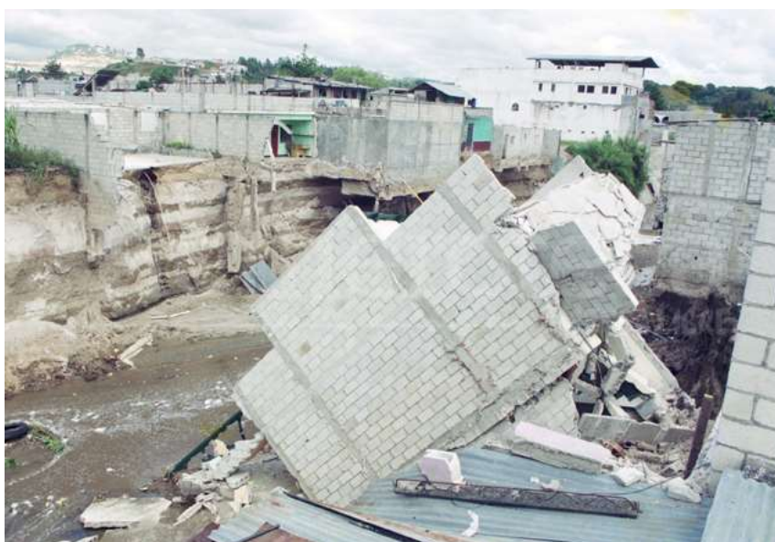
Ilustración 34. Viviendas destruidas por deslaves debido a la crecida del Río Platanitos, en Villa Hermosa, San Miguel Petapa
