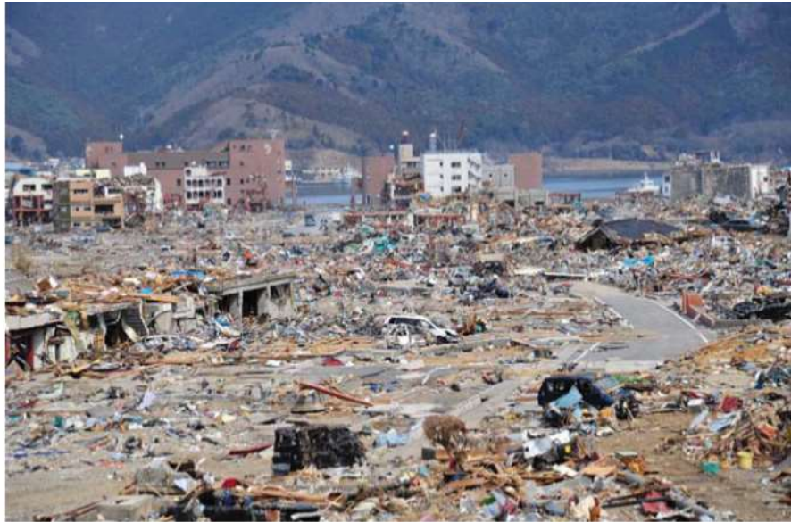
Ilustración 101. Colapso de estructuras en Onagawa,
