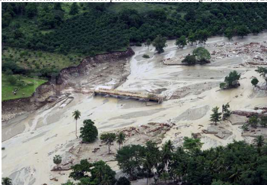
Ilustración 33. Puente Jones destruido por la crecida del Río Motagua, en Teculután, Zacapa.
