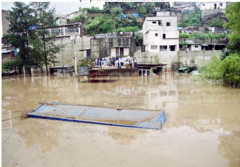
Ilustración 32. - Zonas aledañas al sector metropolitano quedaron inundadas debido a la cantidad de lluvia que presentó el Huracán Mitch.
