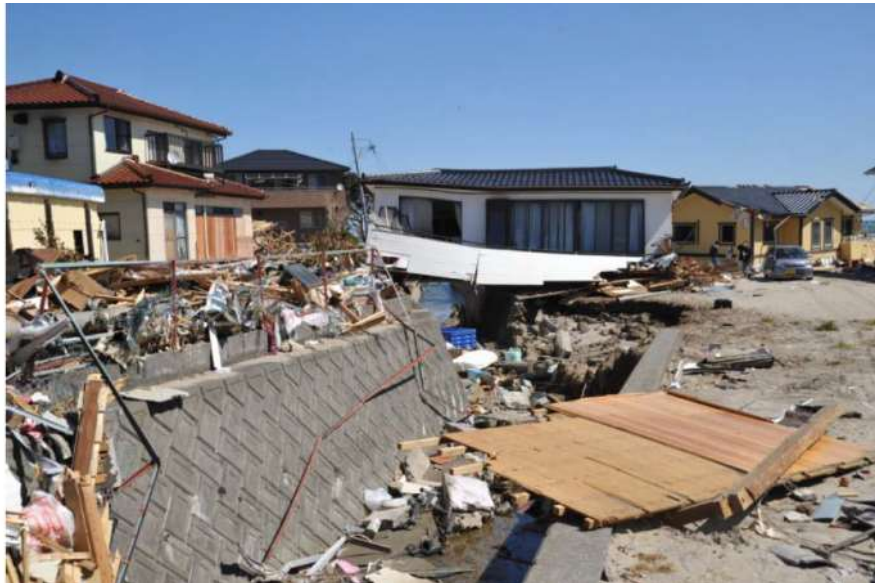
Ilustración 100. Colapso de Viviendas de madera en Iwaki, Japón.
