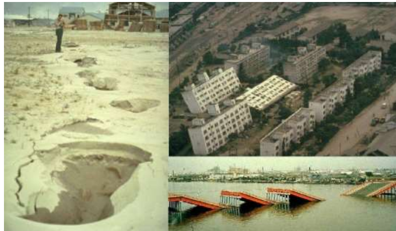
Ilustración 72. Daños producidos en el terremoto de Niigata Japón.
