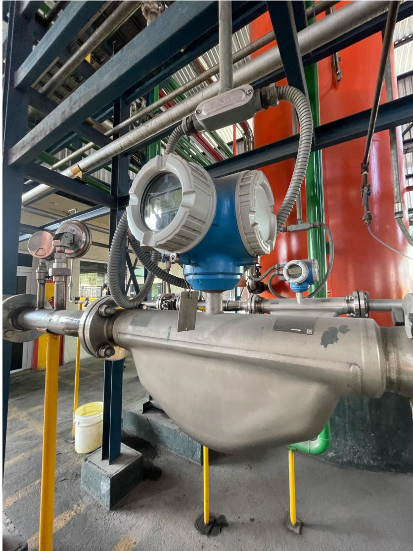
Figura 23: Medidor de flujo másico de coriolis.
