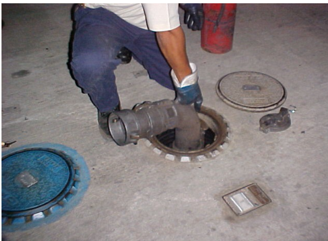
FOTO NO. 9 COLOCACIÓN DE CODOS DE DESCARGA
