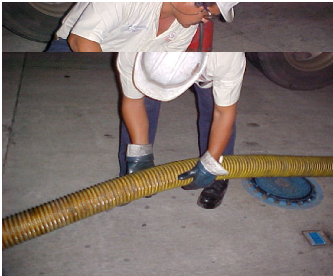
FOTO NO. 8 INSPECCIÓN DE MANGUERA DE DESCARGA
