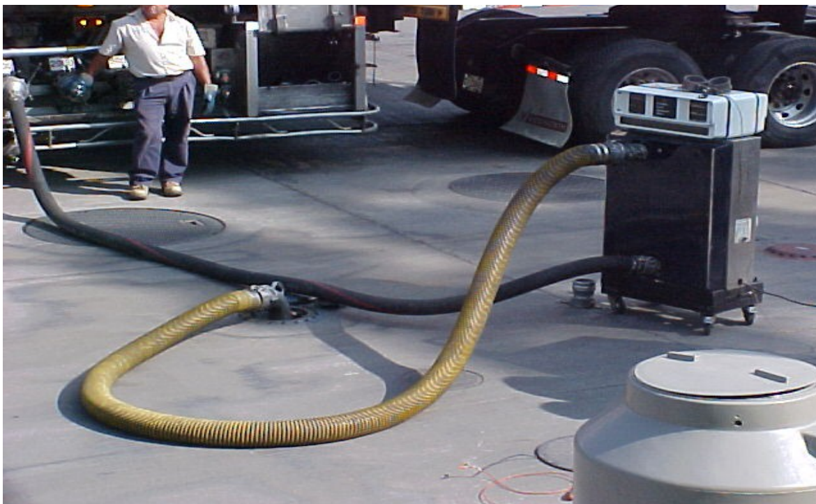
FOTO NO. 15 MÁQUINA CUENTA GALONES CONECTADA A LA MANGUERA DE DESCARGA
