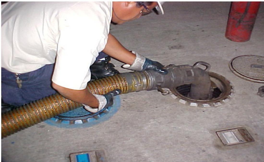
FOTO NO. 10 COLOCACIÓN DE MANGUERA AL CODO DE DESCARGA
