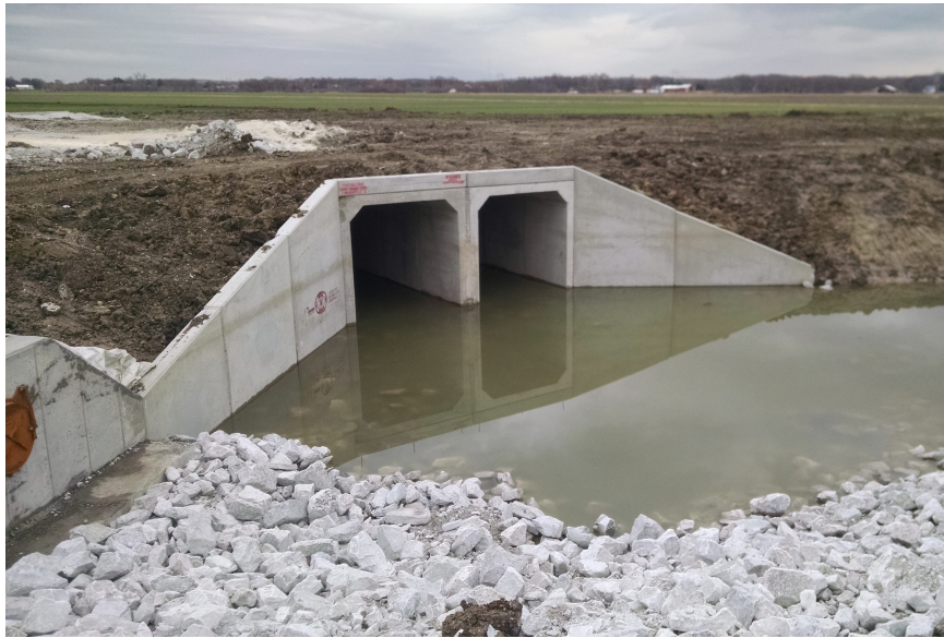
Figura 10. Box Culvert de 2 celdas
