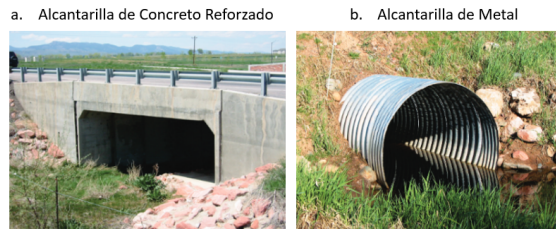
Figura 6. Materiales de construcción de alcantarillas
