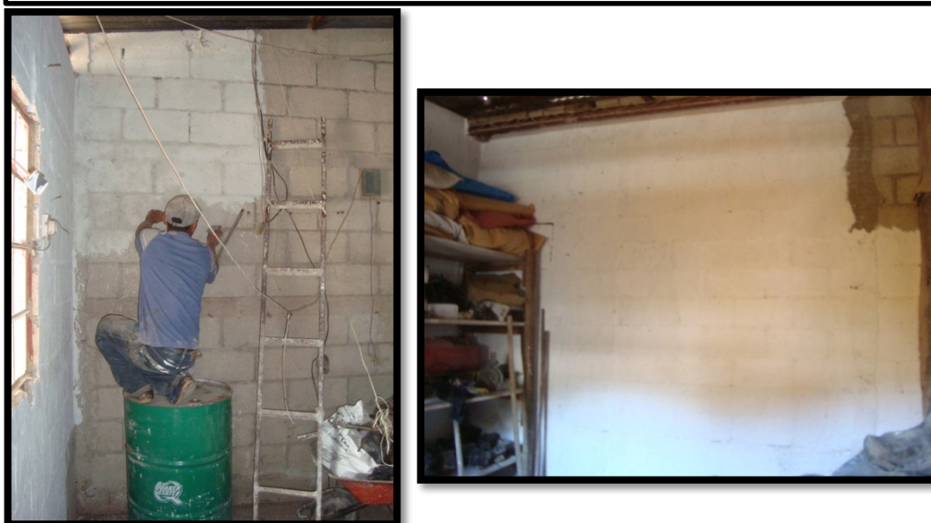
Ilustración 67: Limpieza y aplicación de cal en paredes
