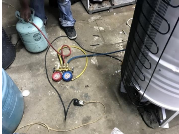
Figura 44. Bomba de vacío.
