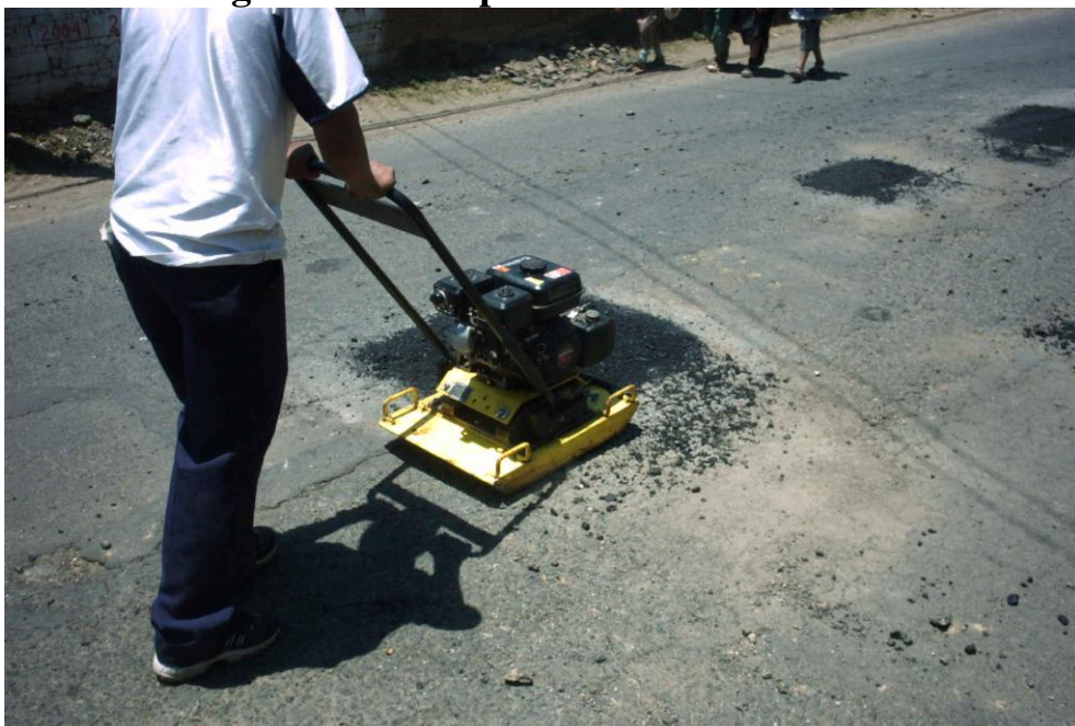
Figura 19. Compactación de mezcla asfáltica.
