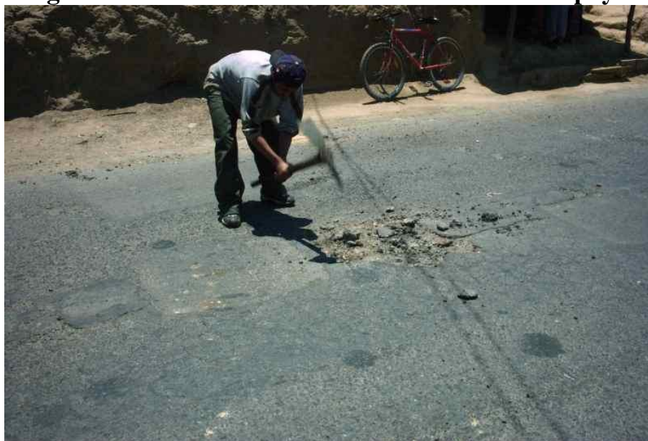
Figura 15. Cuadrando el bache hasta alcanzar apoyo firme.
