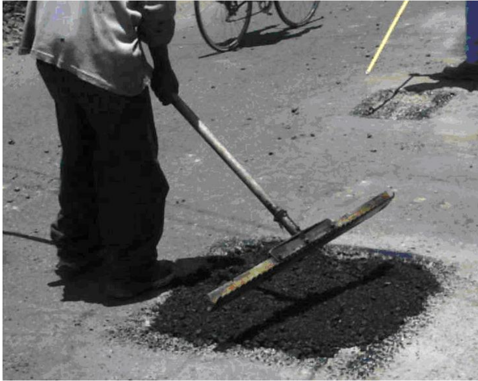
Figura 18. Distribución de mezcla asfáltica en el hueco.
