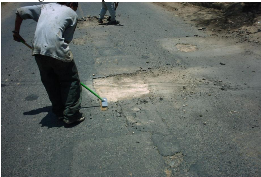
Figura 16. Limpieza del hueco del material suelto.
