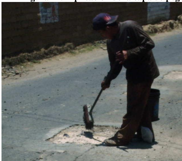
Figura 17. Aplicación de la capa de pega.
