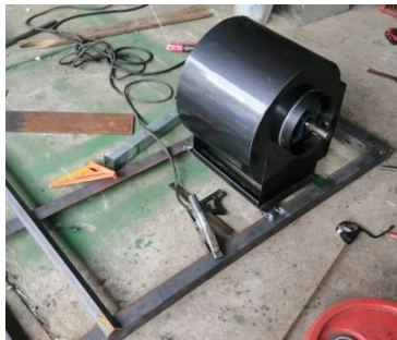
Ilustración 84 Posicionamiento de ventilador centrífugo en la estructura
