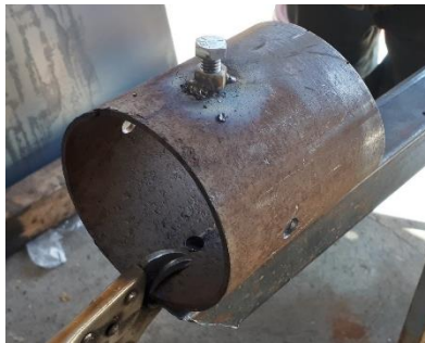
Ilustración 93 Perforación de tubo de 4" y soldadura de tuercas de 3/8"
