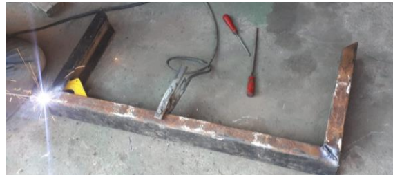
Ilustración 96 Soldadura de los primeros tres elementos de la estructura de la guarda
