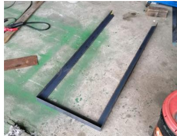
Ilustración 83 Soldadura de marco principal de estructura
