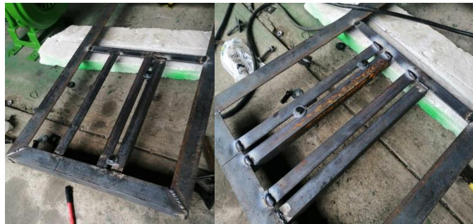
Ilustración 86 Soldadura de perfiles angulares restante en la base del motor
