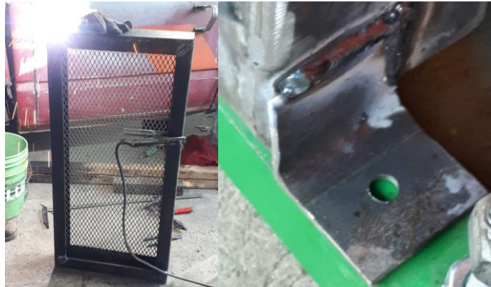
Ilustración 98 Cierre de geometría soldadura de angulares
