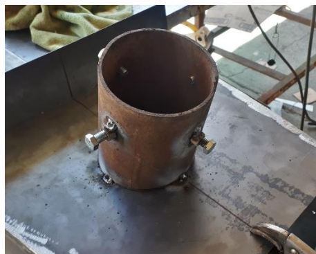
Ilustración 94 Soldadura de tubo de alojamiento de quemador a estructura del difusor
