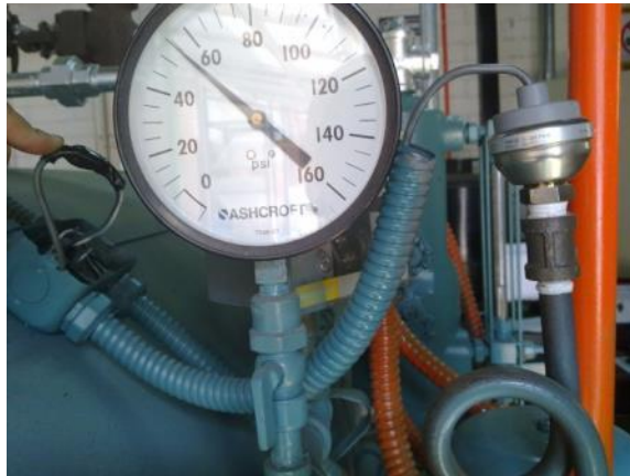
Figura 37: Instalación sensor de presión
