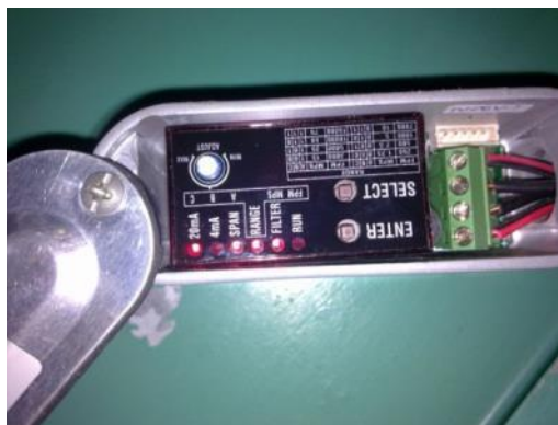
Figura 14: Instalación sensor de velocidad de aire
