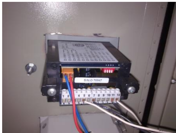
Figura 18: Instalación sensor flujo de agua
