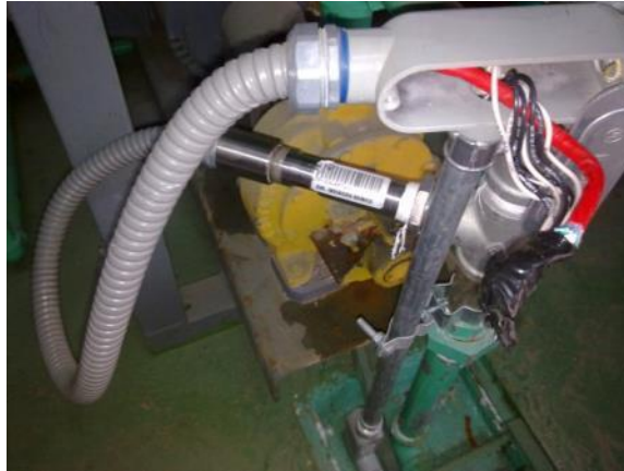
Figura 31: Instalación de sensor de conductividad
