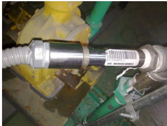
Figura 33: Sensor de conductividad instalado
