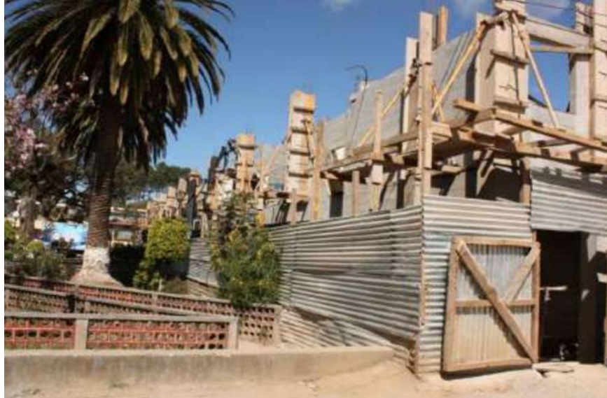
Figura 10. Proceso de construcción del Ecomuseo de San Andrés Semetabaj (Fotografía consultada por: José Menéndez)
