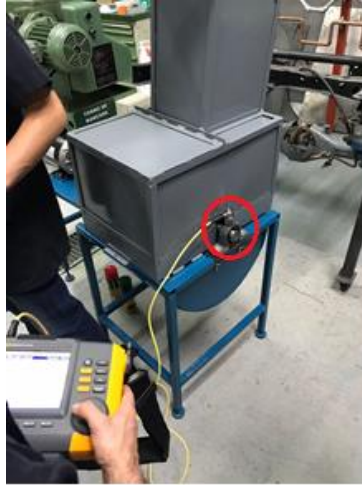
Figura 76. Lectura de vibraciones en chumacera 1
