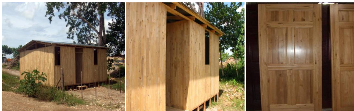
Figura 8. Aplicación de tableros en vivienda popular y puertas
