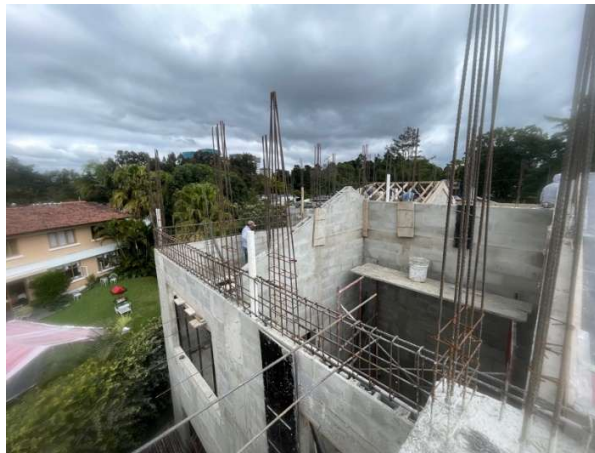
Ilustración 11. Obra gris en fase de construcción
