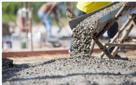
Ilustración 8. Mezcla de concreto
