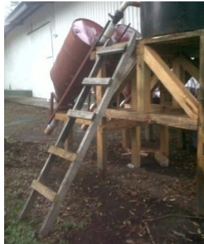
Ilustración 94: Escalera de acceso a la entrada de cámara de carga
