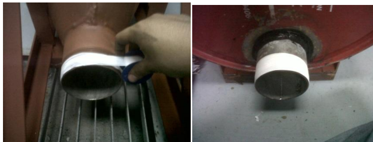
Ilustración 70: Teflón sobre roscas adaptadas a toneles
