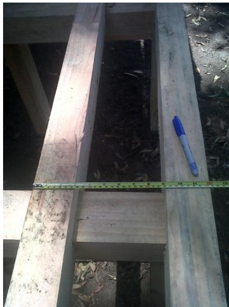
Ilustración 67: Colocación de vigas tipo VI sobre vigas tipo V y tipo II
