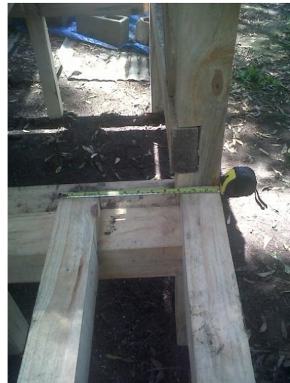
Ilustración 67: Colocación de vigas tipo VI sobre vigas tipo V y tipo II
