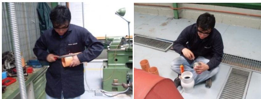
Ilustración 74: Preparación de tubería PVC para ser ensamblada
