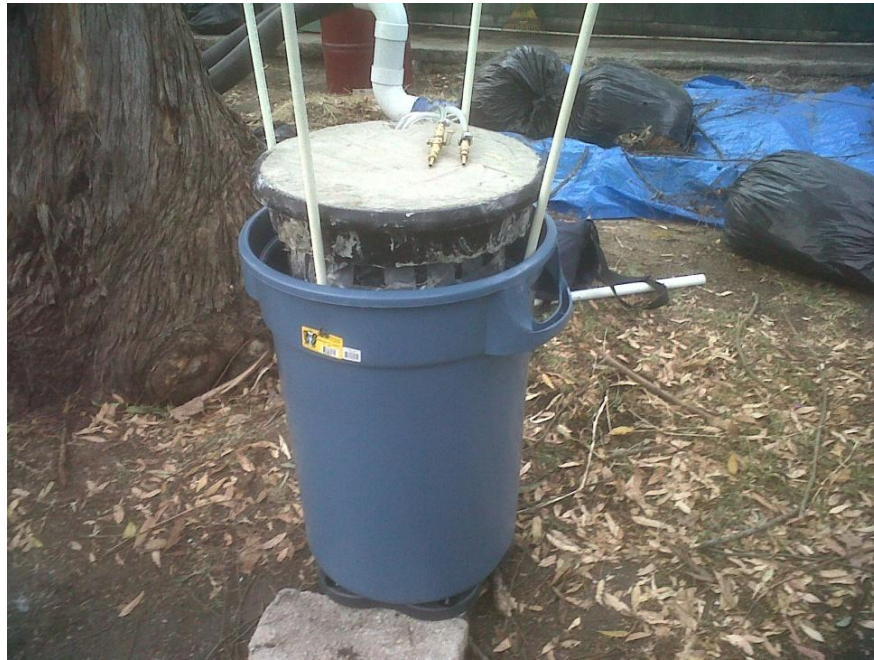
Ilustración 84: Cámara de almacenamiento de gas
