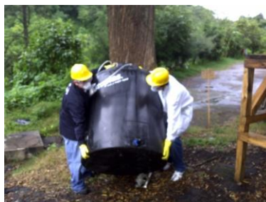
Ilustración 97: Colocación de fosa séptica sobre estructura de madera
