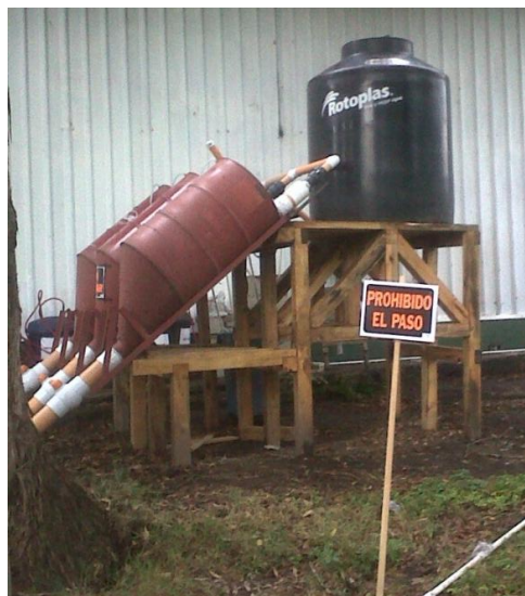
Ilustración 100: Fosa séptica montada sobre estructura de madera
