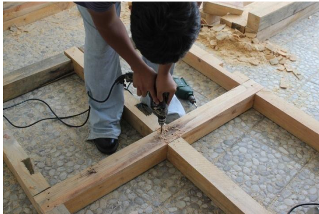
Ilustración 66: Ensamblaje de marco de columnas tipo i y vigas tipo I
