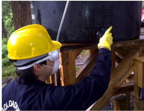
Ilustración 98: Colocación de llave PVC de 1 1/2"
