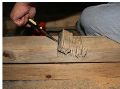
Ilustración 60: Desprendimiento de Madera en Empalmes Intermedios
