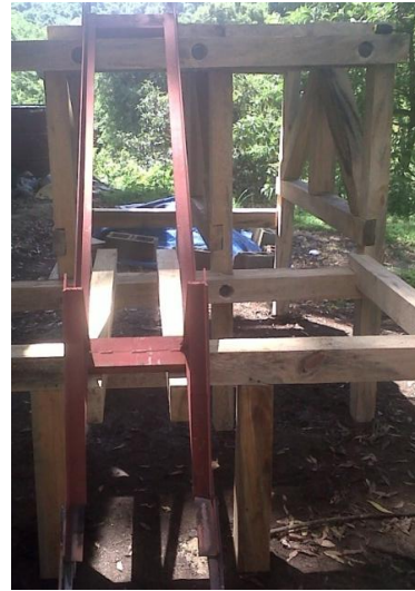
Ilustración 63: Colocación de agujeros para pernos a lo largo de vigas tipo II
