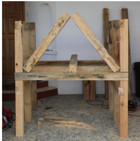
Ilustración 62: Columnas tipo ii cortadas y cazadas en ensamblaje
