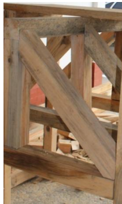
Ilustración 62: Columnas tipo ii cortadas y cazadas en ensamblaje
