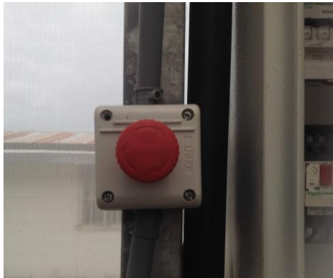
Figura 17. Stop de emergencia para detener el motor de la cortina UV
