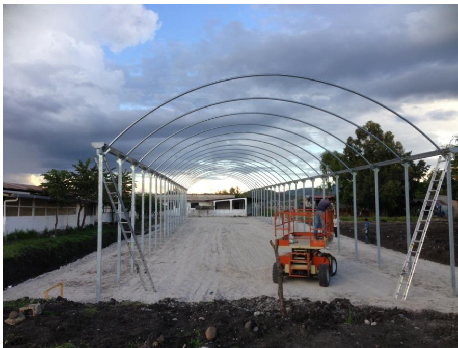
Figura 8. Inicio de construcción de Invernadero de la finca “Joshua”, Jalapa
