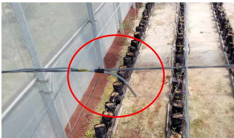
Figura 30. Sensor de temperatura del termostato digital
