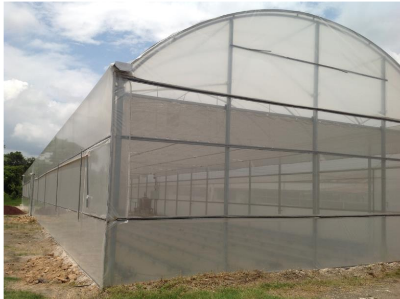
Figura 10. Invernadero de la finca “Joshua” terminado.
