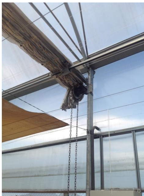
Figura 13. Mecanismo polea- cadena para accionar la cortina UV
