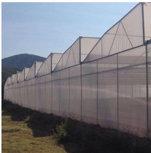
Figura 3. Invernadero diente de sierra, ubicado en Puebla, México. [10]
