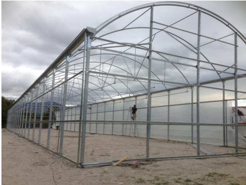
Figura 9. Estructura del invernadero fabricada con tubería galvanizada
