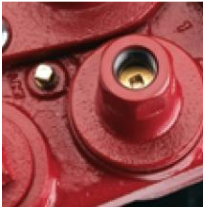
LIBERACIÓN DE PRESIÓN DE LA CHECK VALVE. IMAGEN RED JACKET.
