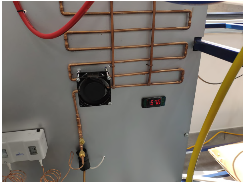
Figura 47: Temperatura a la salida del compresor
