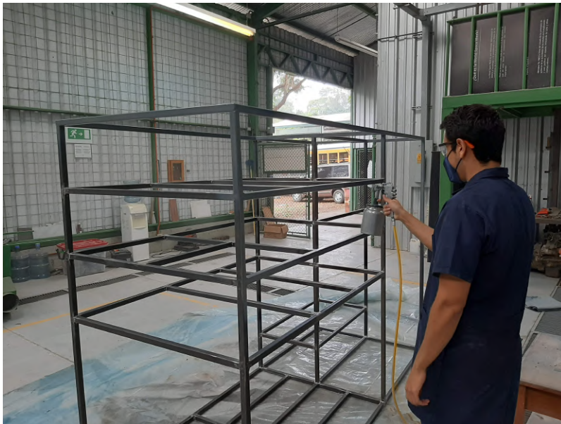
Figura 34: Pintura gris base para la estructura
