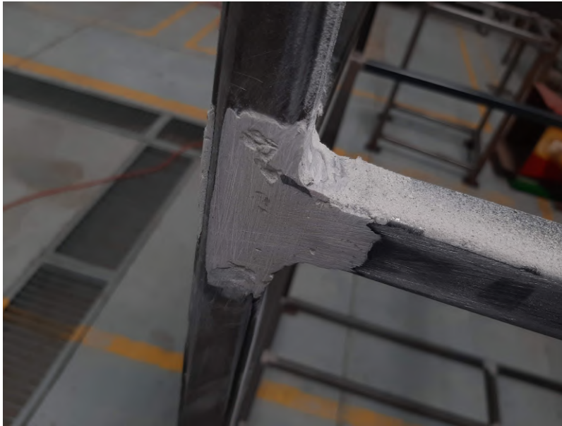
Figura 33: Mejoramiento de acabados con masilla
