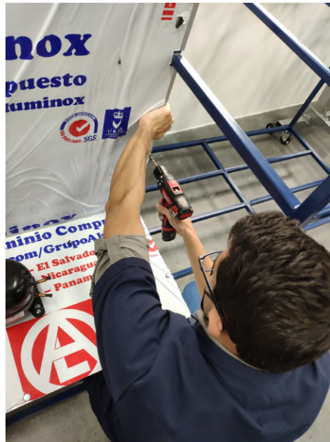
Figura 37: Instalación de plancha de ACM para componentes de refrigeración
