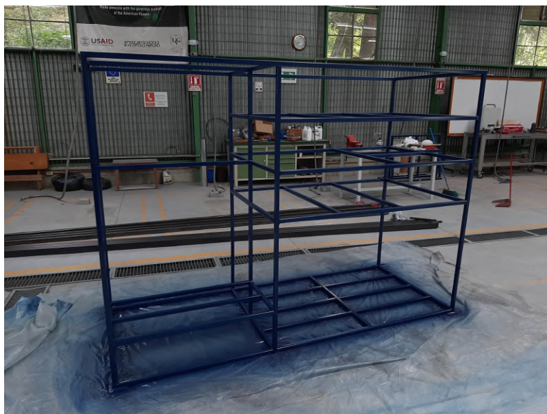
Figura 35: Pintura azul para la estructura
