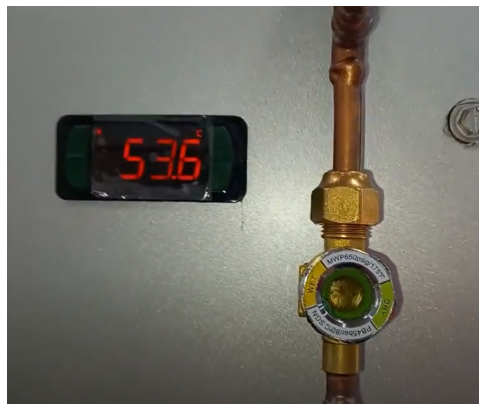
Figura 45: Revisión visor de líquido
