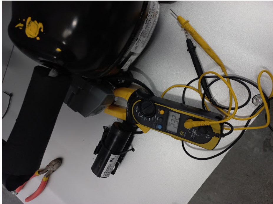
Figura 44: Lectura con el amperímetro en el compresor
