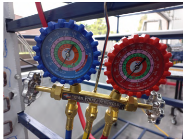
Figura 60: Prueba de vacío del sistema de refrigeración
